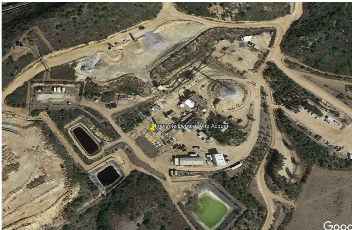
Figura 1 Impianto di depurazione
