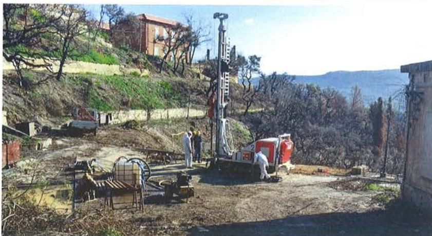
Figura 11 – Sonda cingolata impiegata per l'esecuzione dei sondaggi
