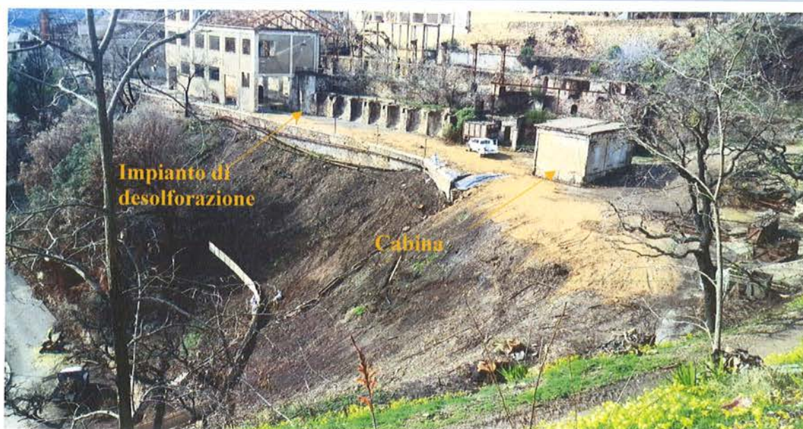
Figura 3 – Visione panoramica dell'area d'indagine
