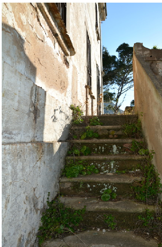
Foto 10: Edificio 2 - Villa Stefani - Foglio 5 mapp.22
