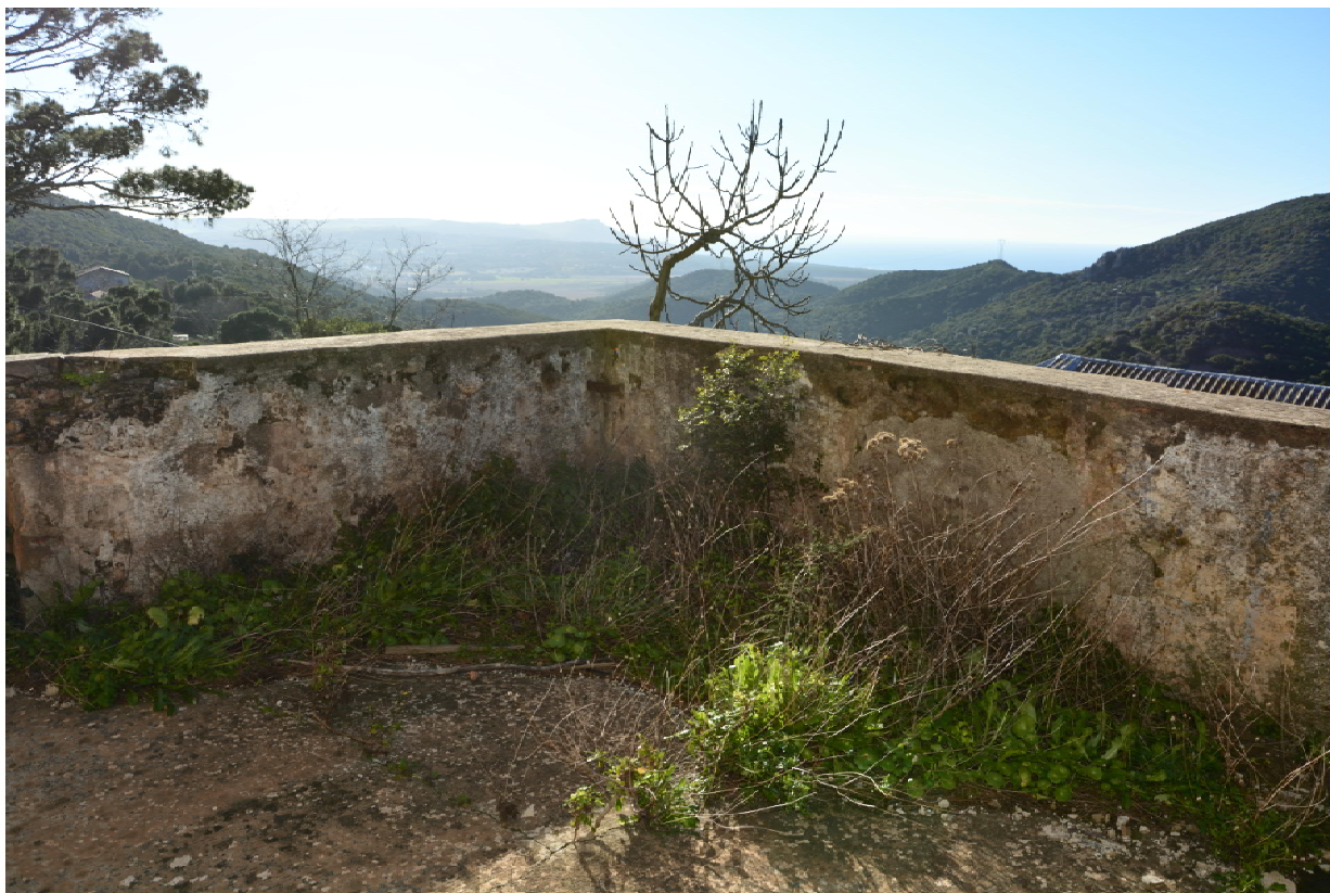
Foto 9: Edificio 2 - Villa Stefani - Foglio 5 mapp.22
