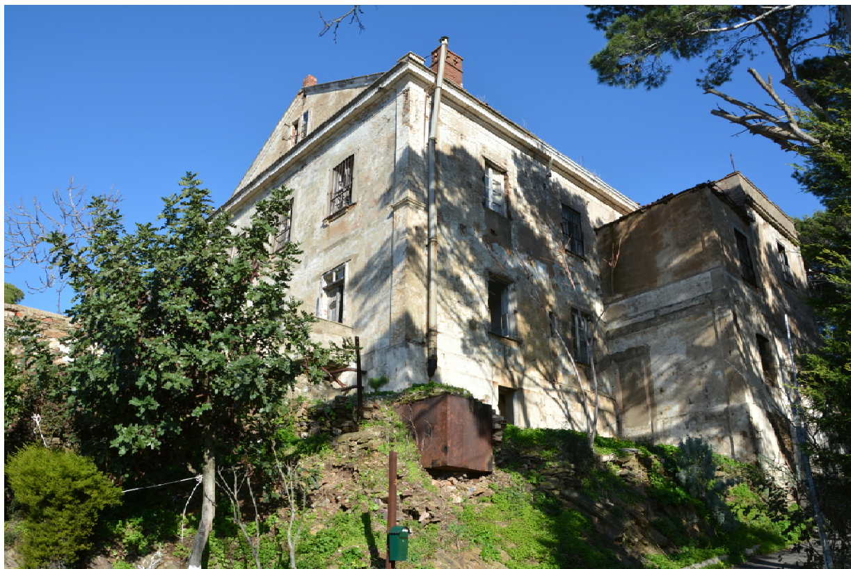
Foto 8: Edificio 2 - Villa Stefani - Foglio 5 mapp.22
