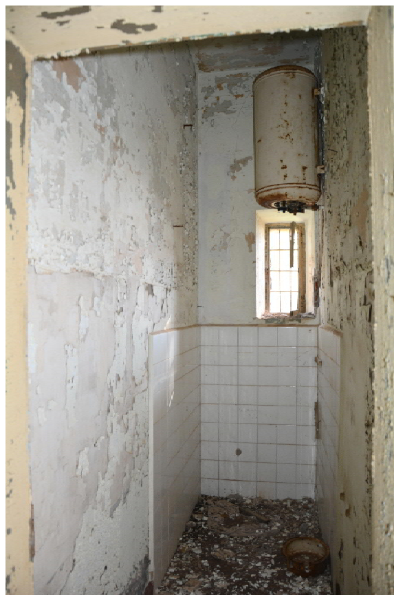
Foto 12: Edificio 2 - Villa Stefani - Foglio 5 mapp.22
