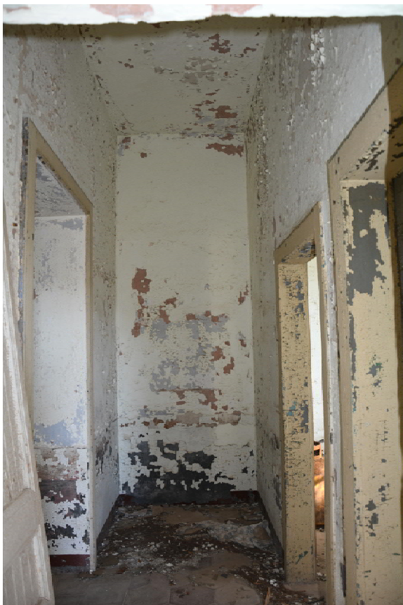
Foto 11: Edificio 2 - Villa Stefani - Foglio 5 mapp.22
