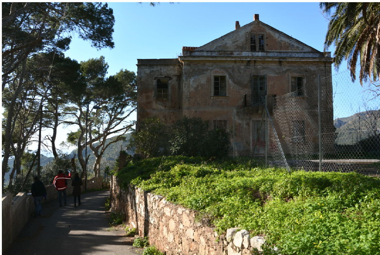
Foto 7: Edificio 2 - Villa Stefani - Foglio 5 mapp.22
