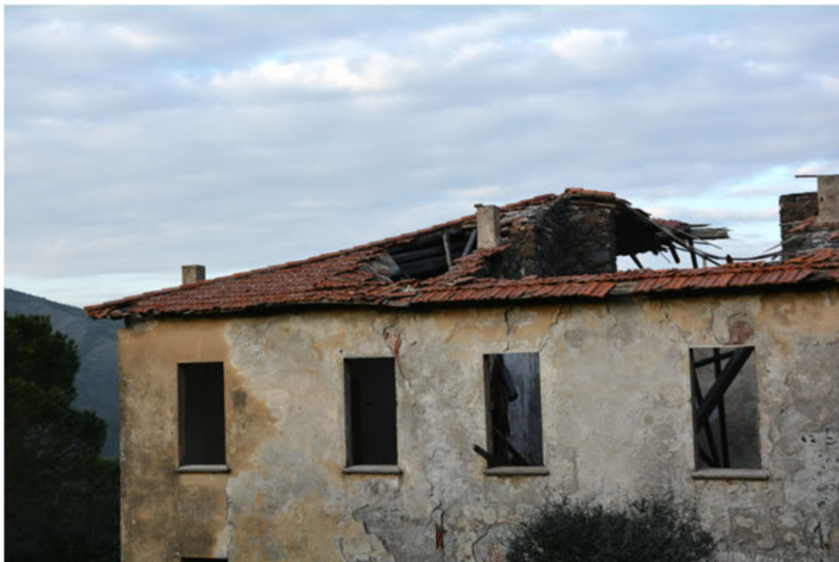
Foto 34: Edificio 10 - Foglio 404 mapp.145
