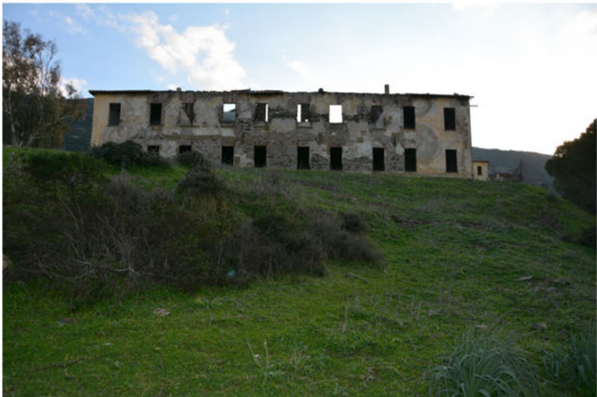
Foto 28: Edificio 9 - Foglio 404 mapp.146
