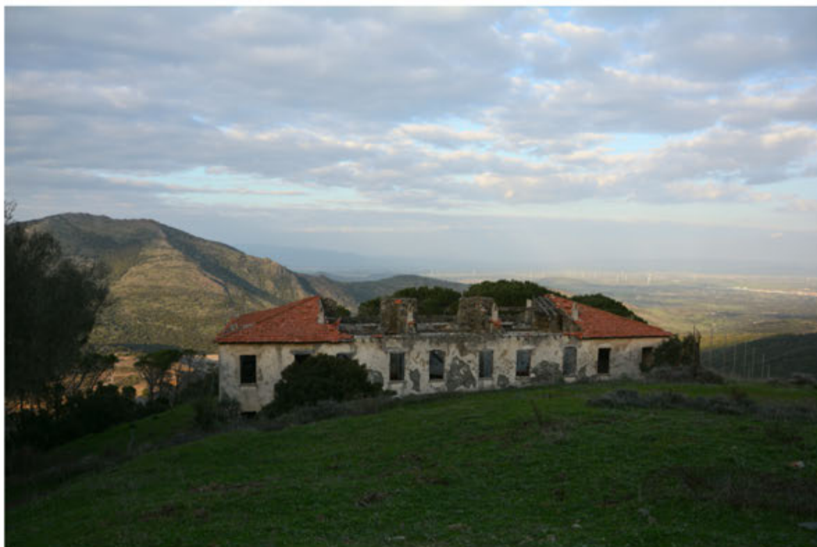
Foto 37: Edificio 11 - Foglio 404 mapp.144
