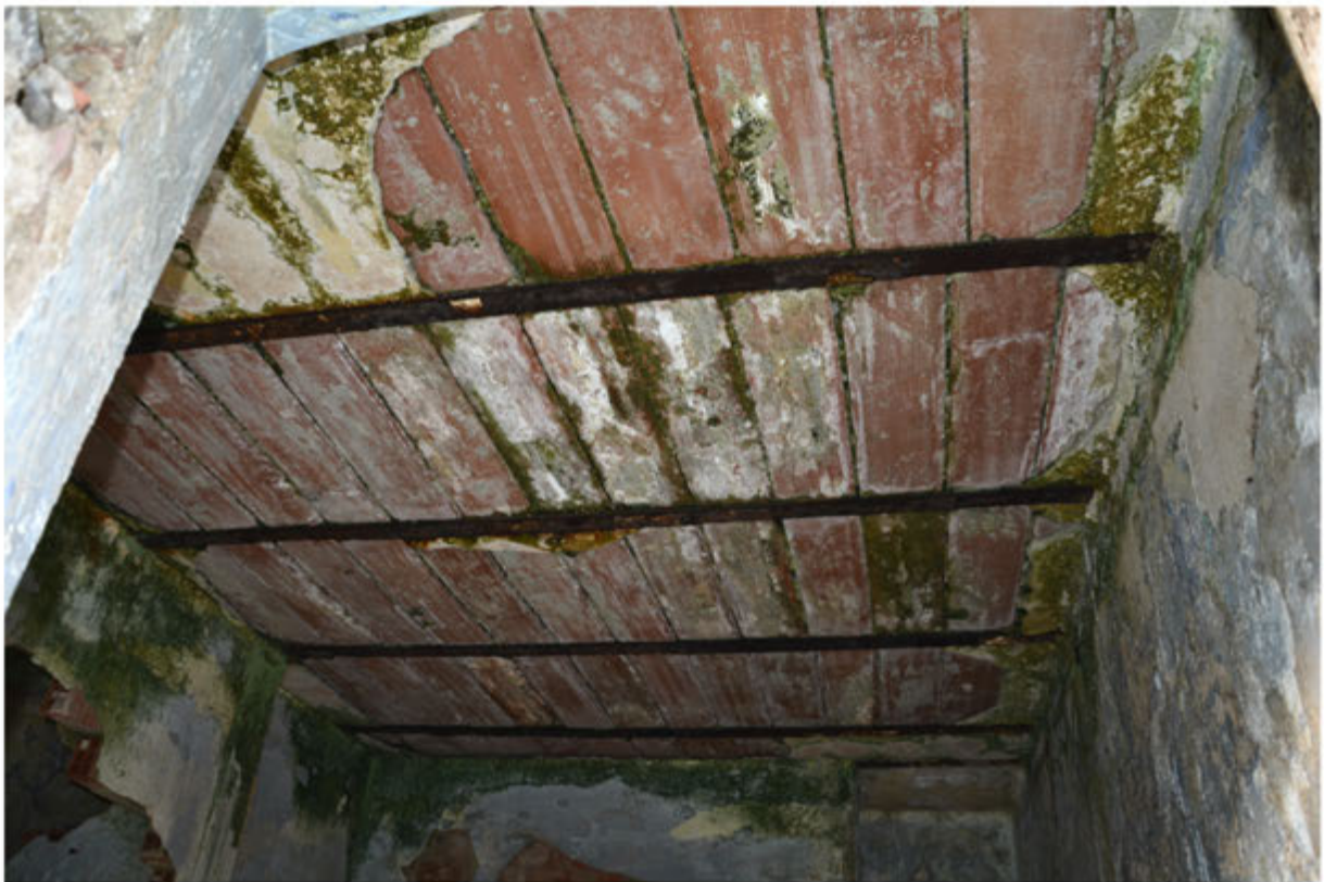
Foto 32: Edificio 9 - Foglio 404 mapp.146
