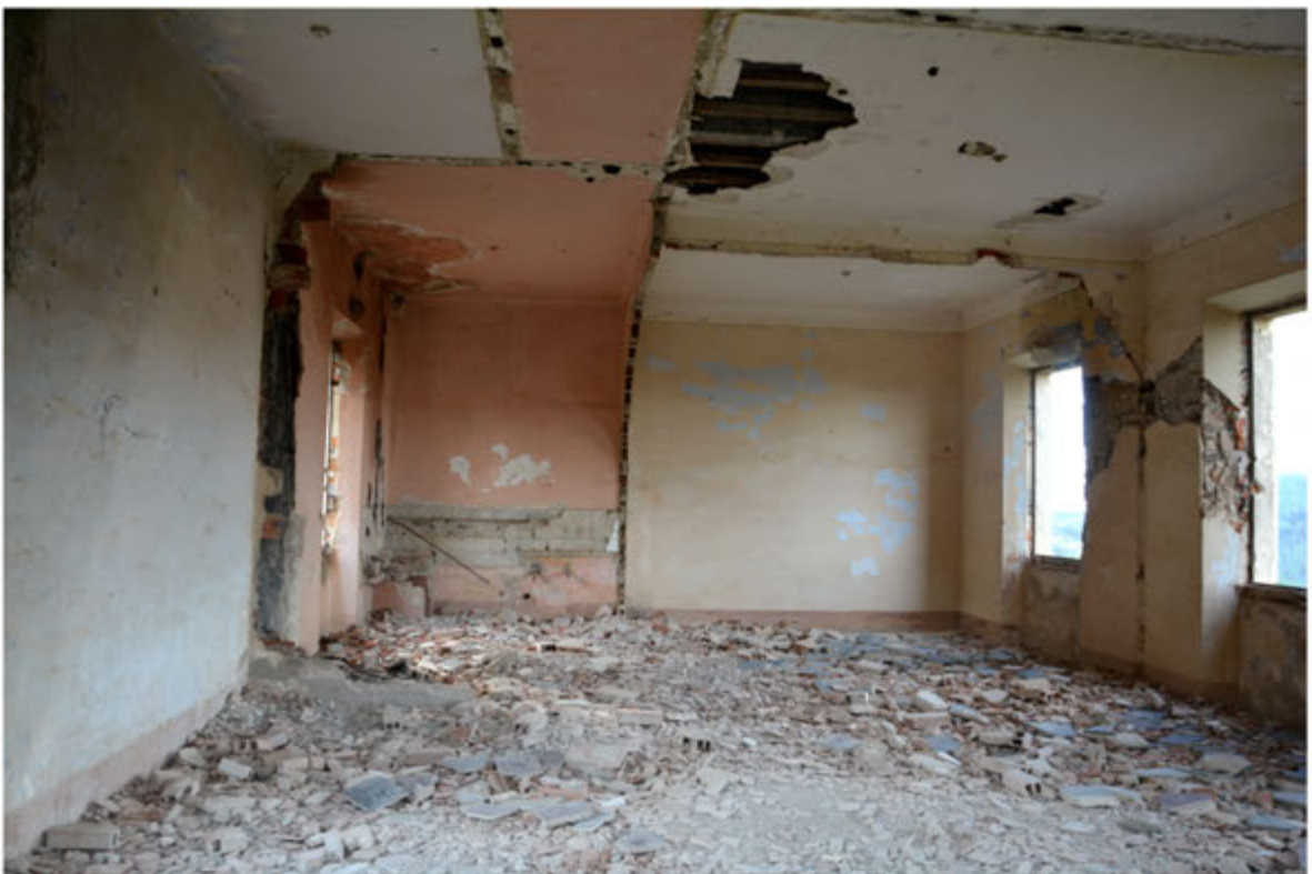
Foto 10: Edificio 4 - Foglio 701 mapp.50
