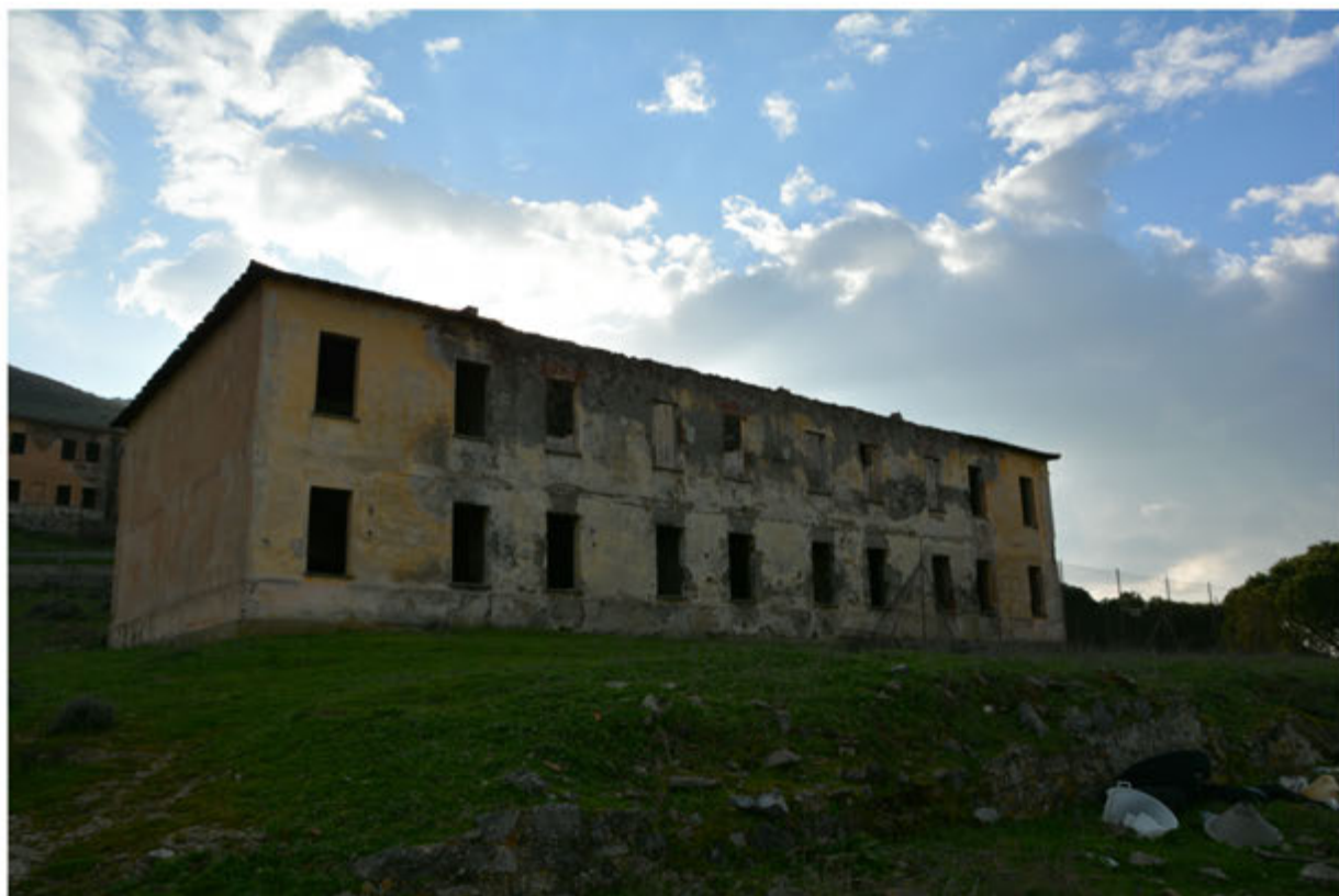
Foto 23: Edificio 8 - Foglio 404 mapp.147
