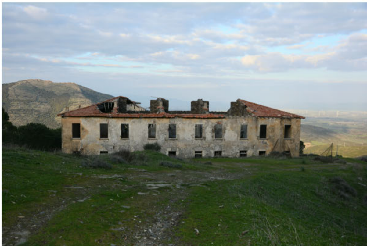
Foto 33: Edificio 10 - Foglio 404 mapp.145
