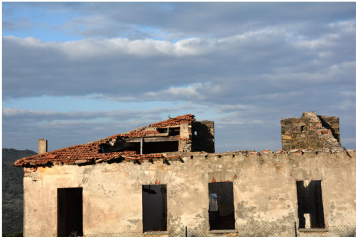
Foto 30: Edificio 9 - Foglio 404 mapp.146
