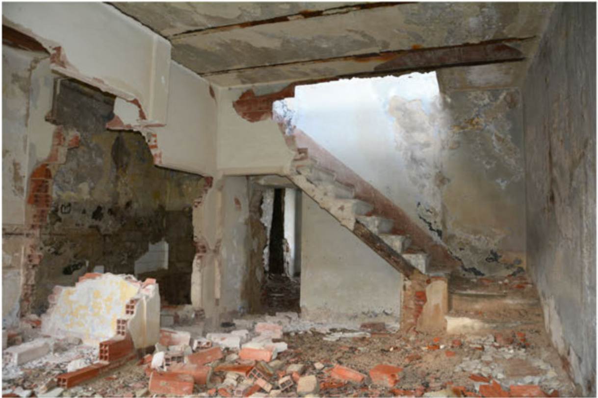
Foto 31: Edificio 9 - Foglio 404 mapp.146
