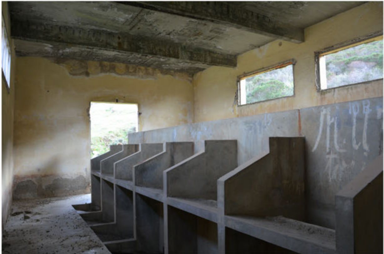
Foto 3: Edificio 1 - Foglio 701 mapp.45
