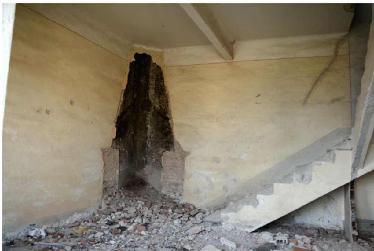
Foto 18: Edificio 6 - Foglio 404 mapp.153
