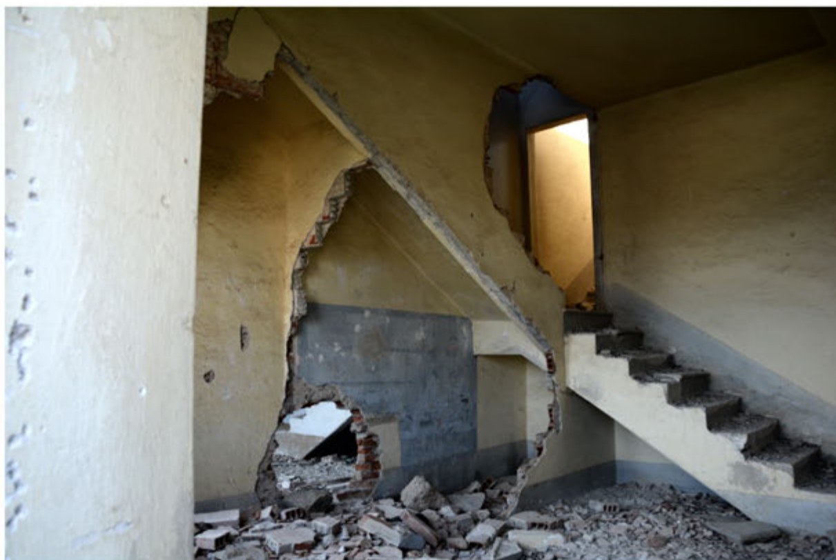
Foto 19: Edificio 6 - Foglio 404 mapp.153
