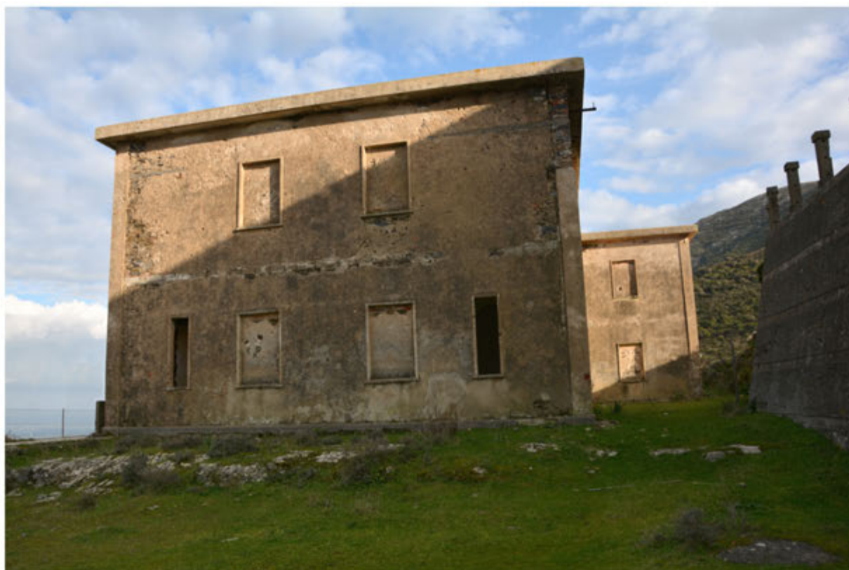
Foto 15: Edificio 6 - Foglio 404 mapp.153
