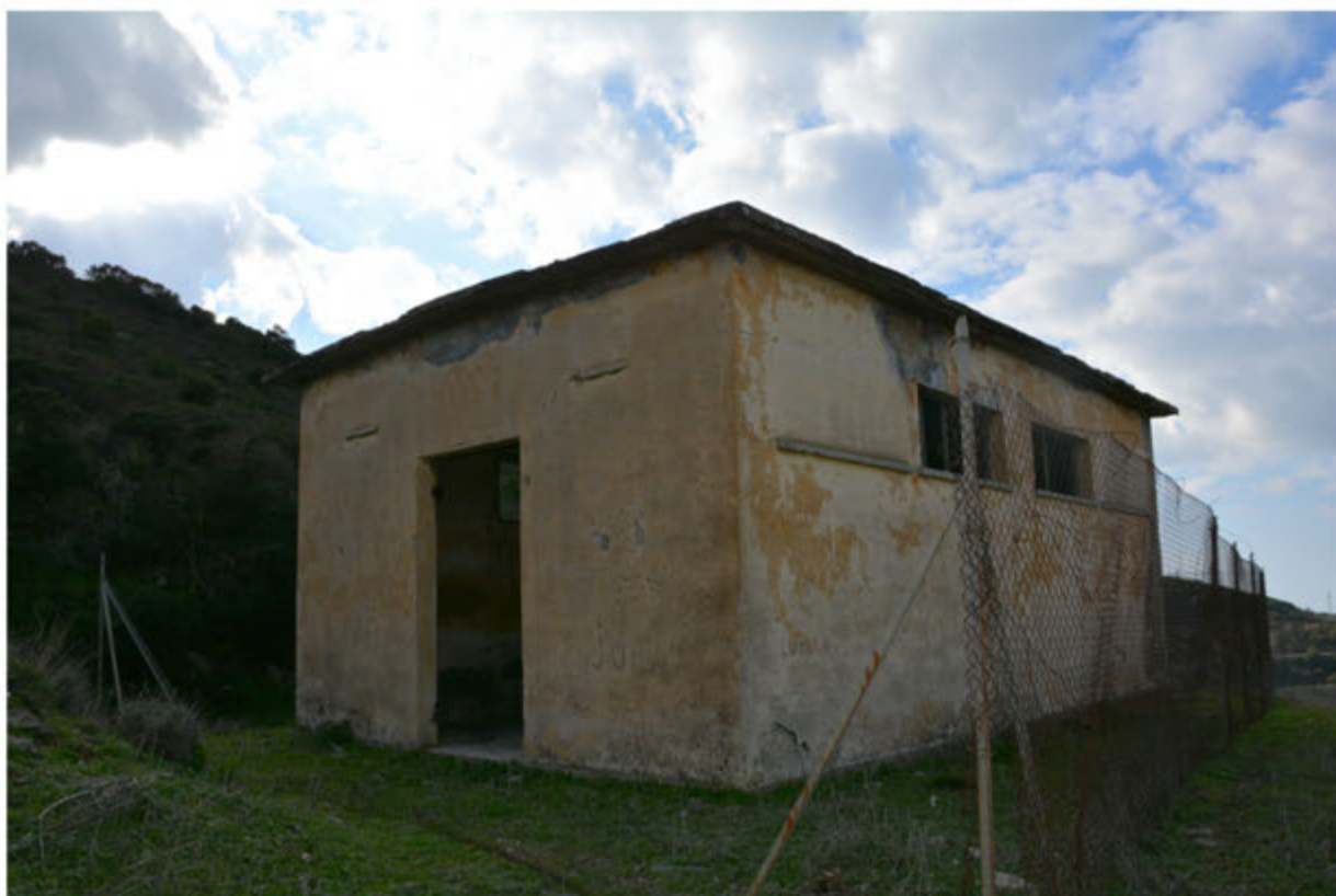
Foto 2: Edificio 1 - Foglio 701 mapp.45
