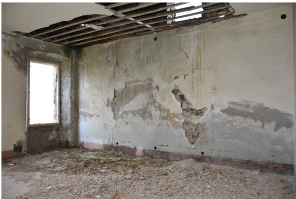
Foto 26: Edificio 8 - Foglio 404 mapp.147
