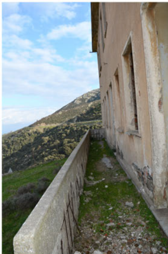
Foto 17: Edificio 6 - Foglio 404 mapp.153
