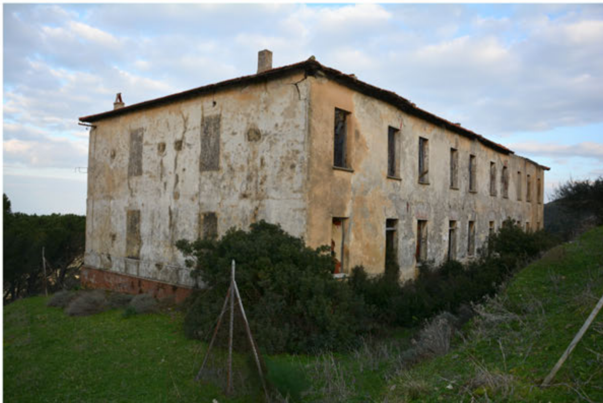
Foto 35: Edificio 10 - Foglio 404 mapp.145
