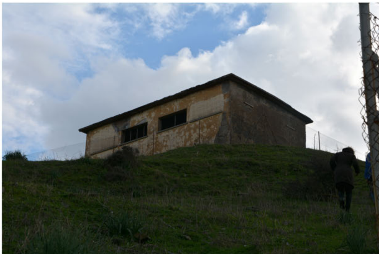
Foto 1: Edificio 1 - Foglio 701 mapp.45
