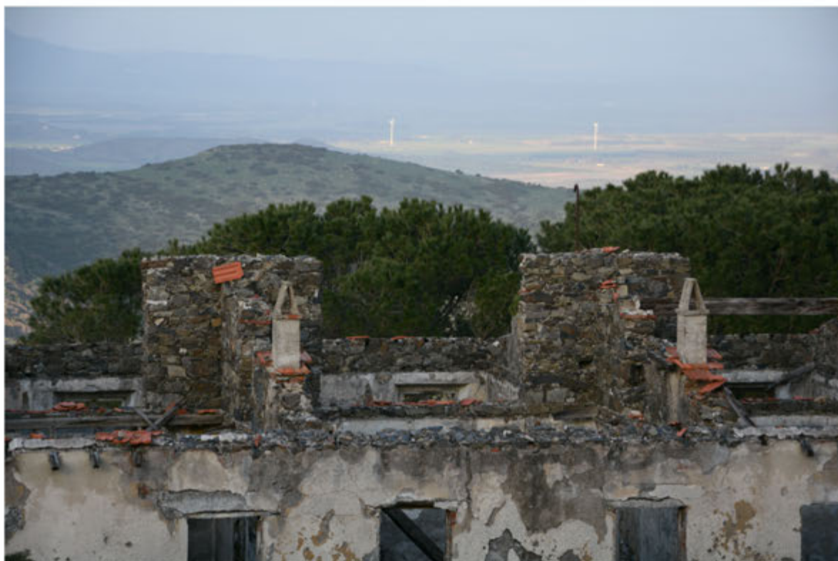
Foto 38: Edificio 11 - Foglio 404 mapp.144
