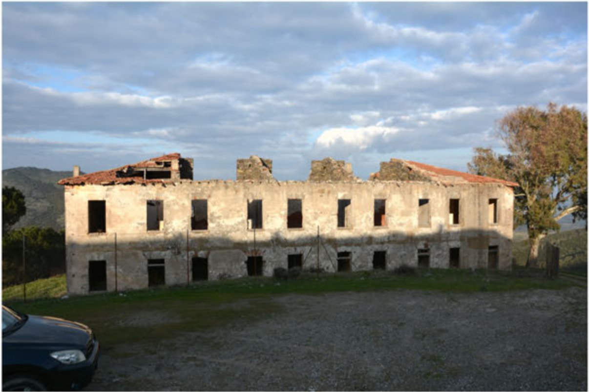
Foto 29: Edificio 9 - Foglio 404 mapp.146
