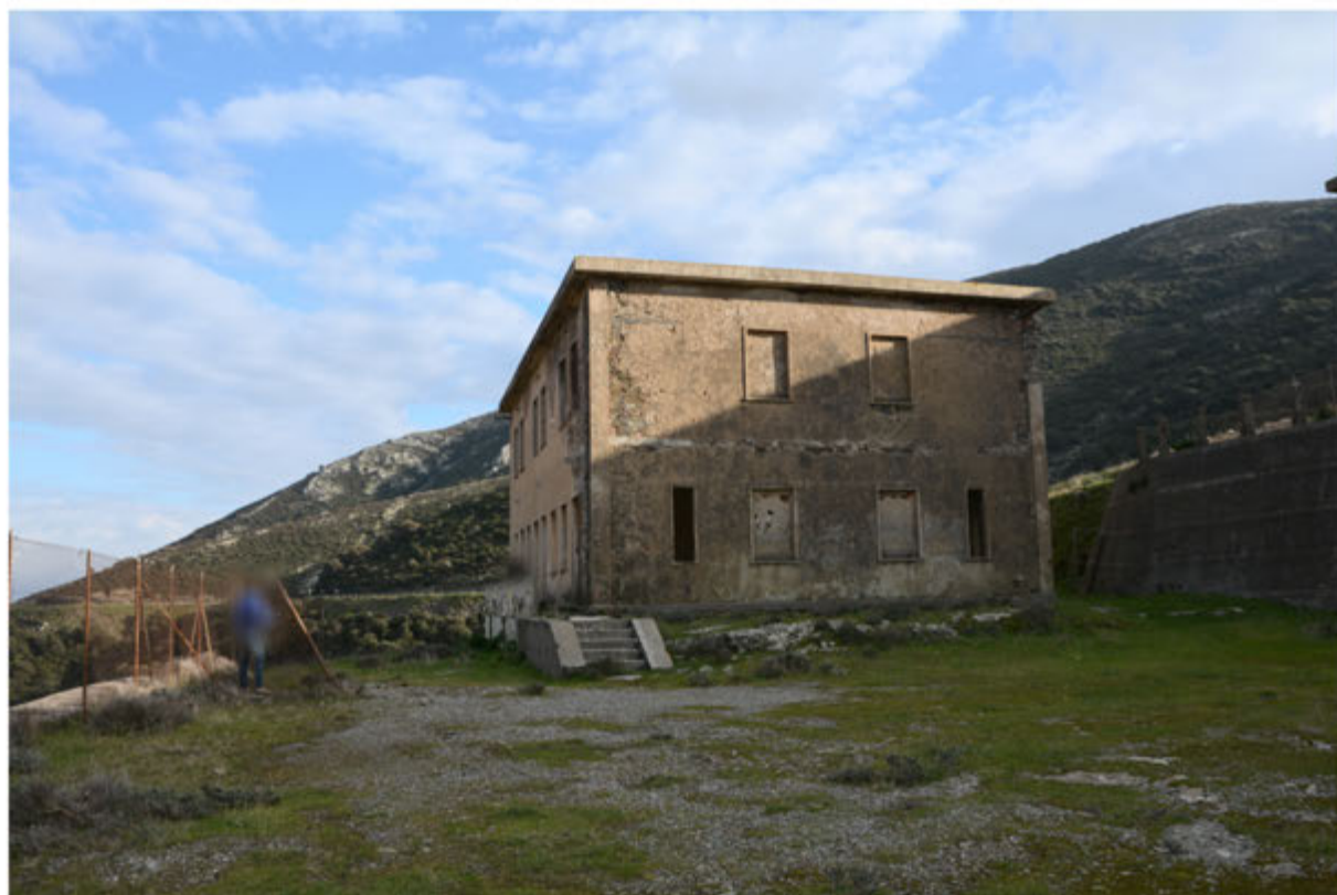
Foto 16: Edificio 6 - Foglio 404 mapp.153
