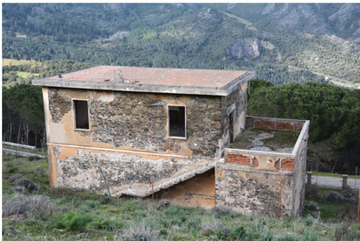
Foto 8: Edificio 4 - Foglio 701 mapp.50
