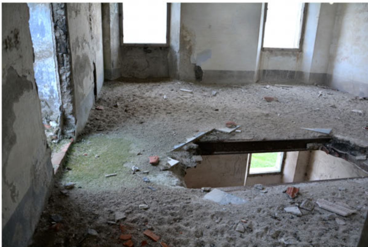
Foto 25: Edificio 8 - Foglio 404 mapp.147
