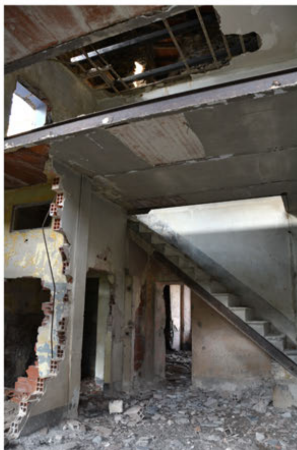
Foto 24: Edificio 8 - Foglio 404 mapp.147
