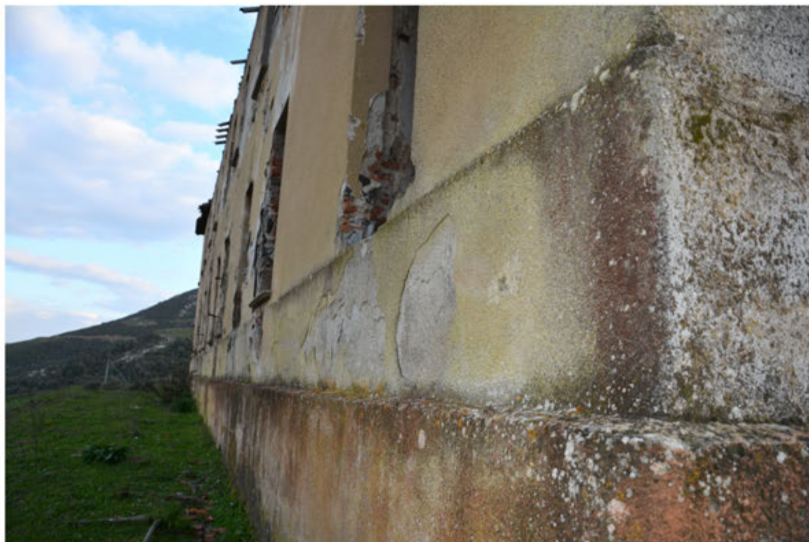
Foto 36: Edificio 10 - Foglio 404 mapp.145
