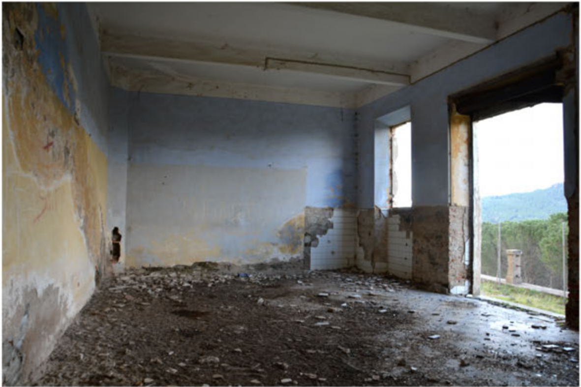
Foto 9: Edificio 4 - Foglio 701 mapp.50
