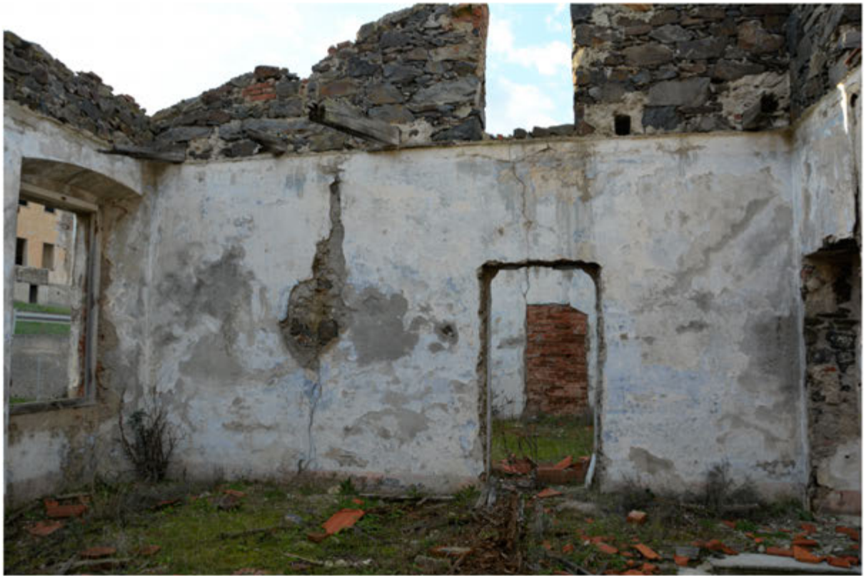
Foto 27: Edificio 8 - Foglio 404 mapp.147
