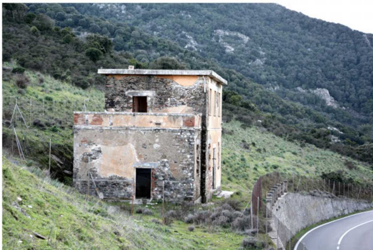
Foto 7: Edificio 4 - Foglio 701 mapp.50
