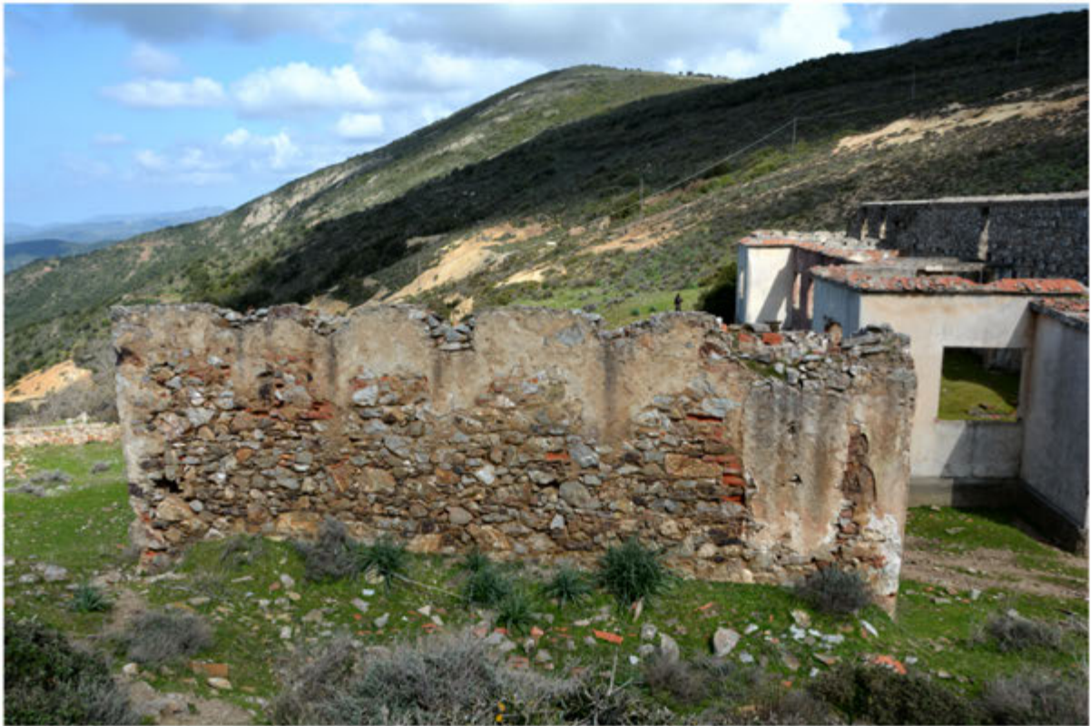
Foto 29: Edificio 8 - Foglio 512 terreno in mapp.31
