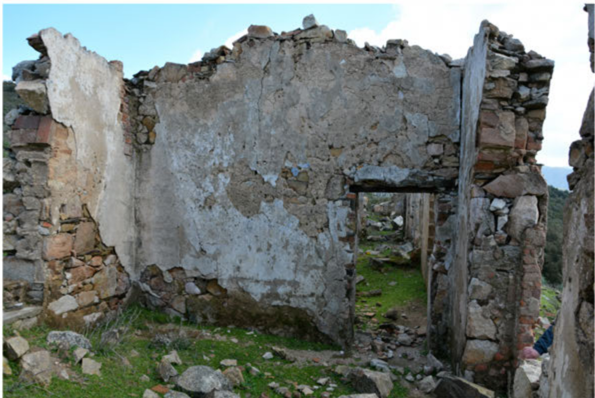
Foto 12: Edificio 3 - Foglio 512 mapp.36
