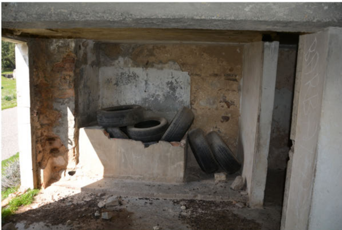
Foto 5: Edificio 1 - Foglio 512, terreno in mappale mapp.65 Ufficio Postale - piano seminterrato
