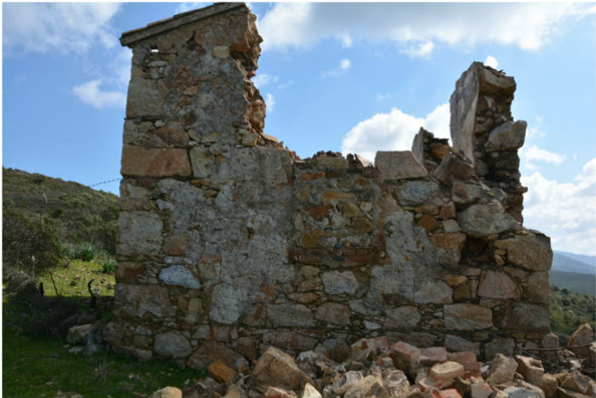
Foto 11: Edificio 3 - Foglio 512 mapp.36
