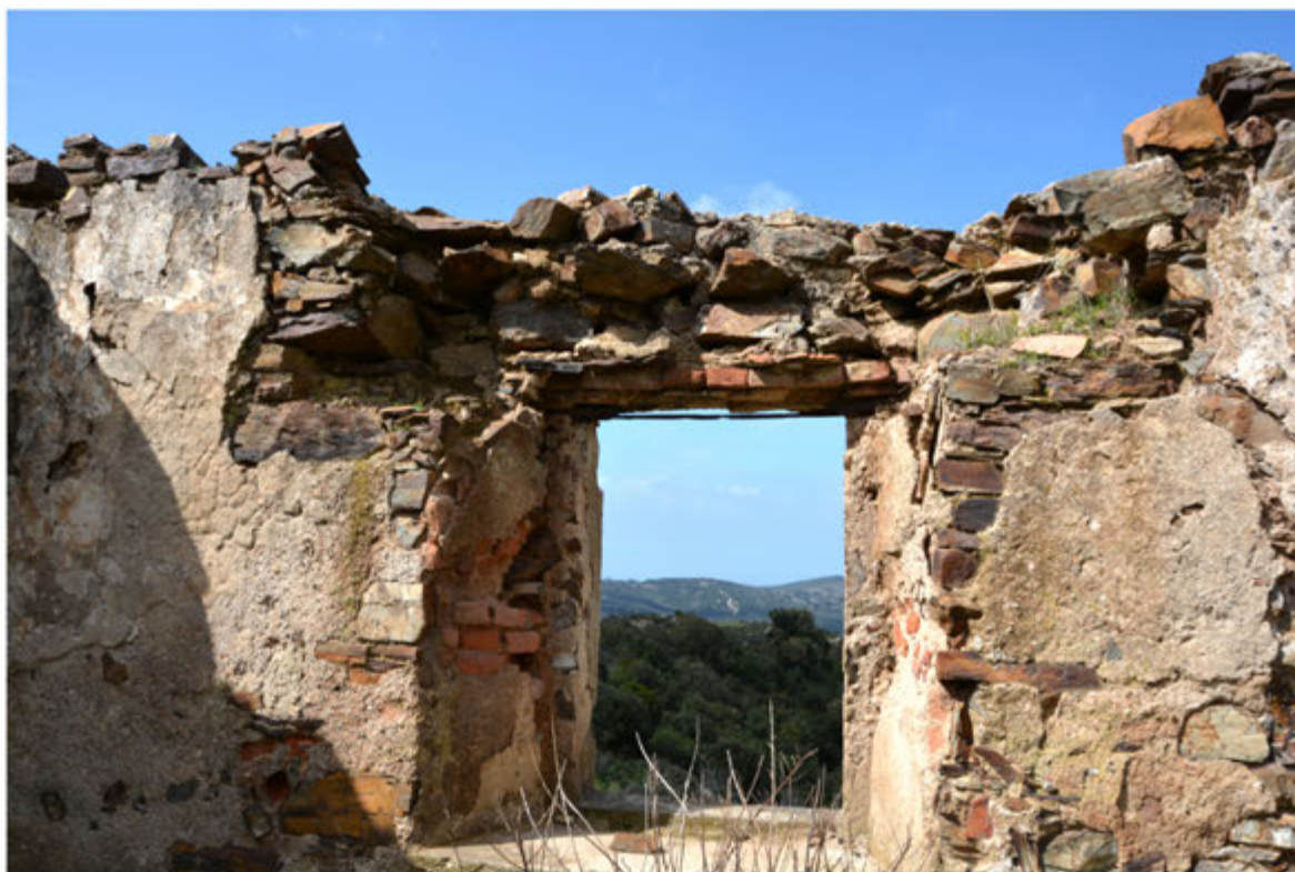
Foto 16: Edificio 4 - Foglio 512 terreno in mapp.58
