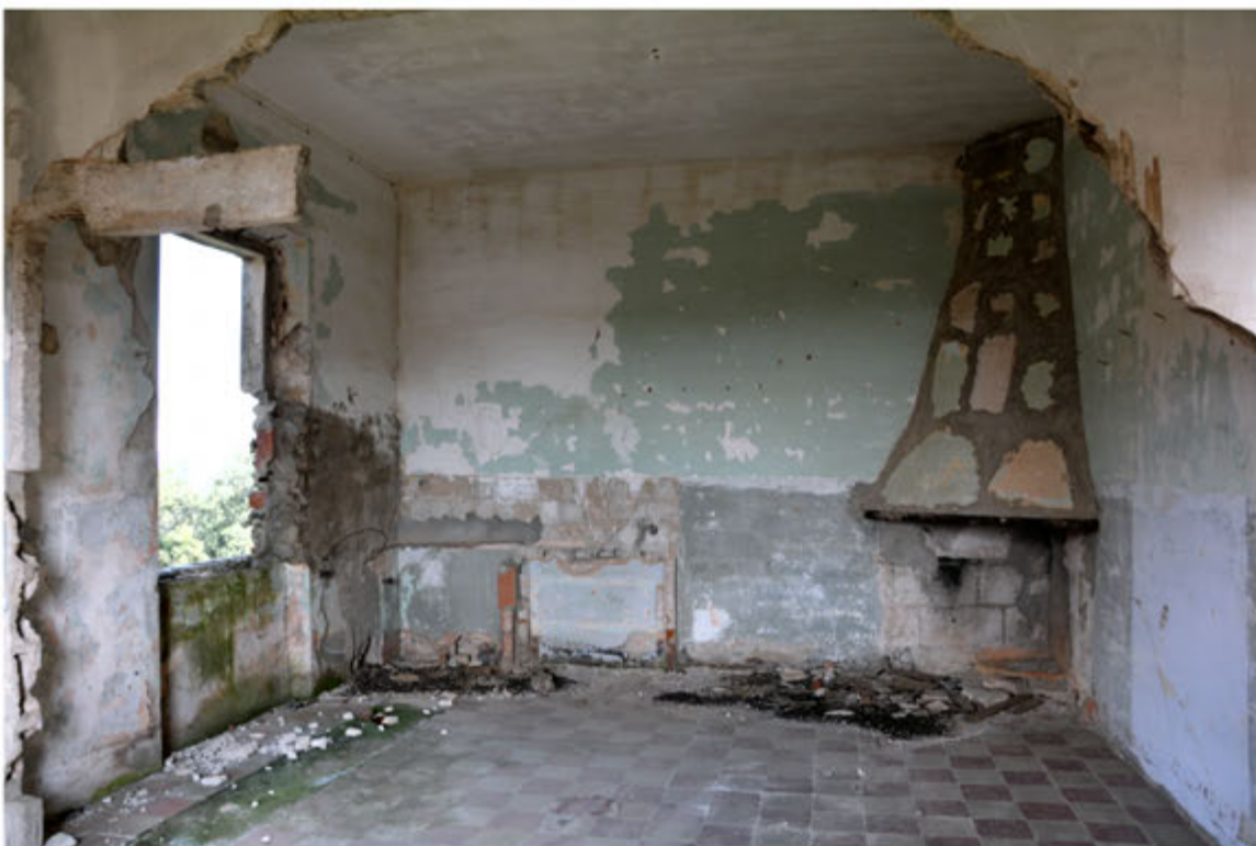
Foto 61: Edificio 22 - Foglio 514 mapp.37
