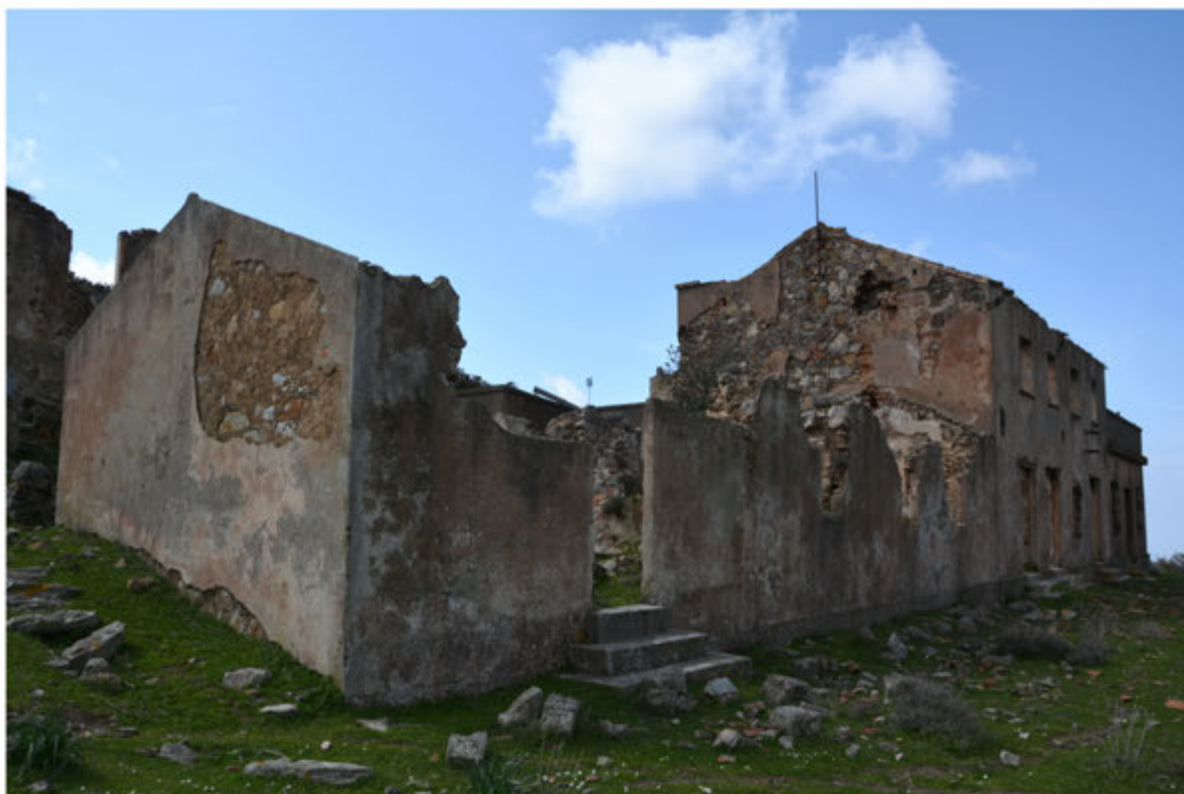
Foto 22: Edificio 6 - Foglio 512 terreno in mapp.31
