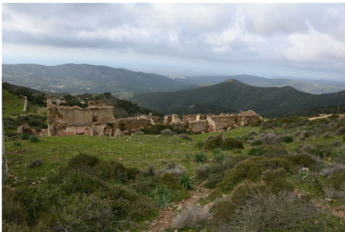
Foto 34: Edificio 10 - Foglio 512 terreno in mapp.58
