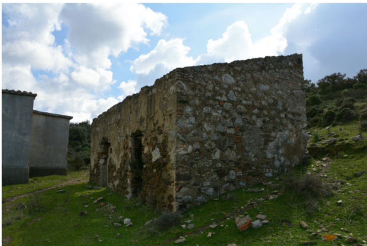
Foto 28: Edificio 8 - Foglio 512 terreno in mapp.31
