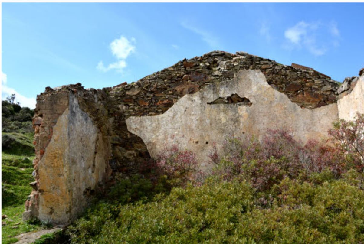
Foto 27: Edificio 7c - Foglio 512 terreno in mapp.31
