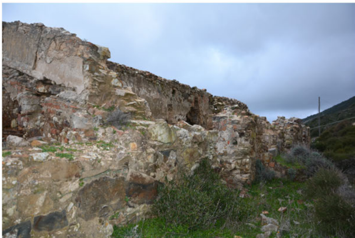
Foto 35: Edificio 10 - Foglio 512 terreno in mapp.58
