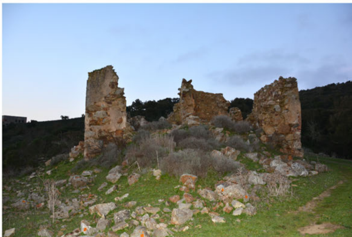
Foto 54: Edificio 19 - Foglio 512 - terreno in mapp.65
