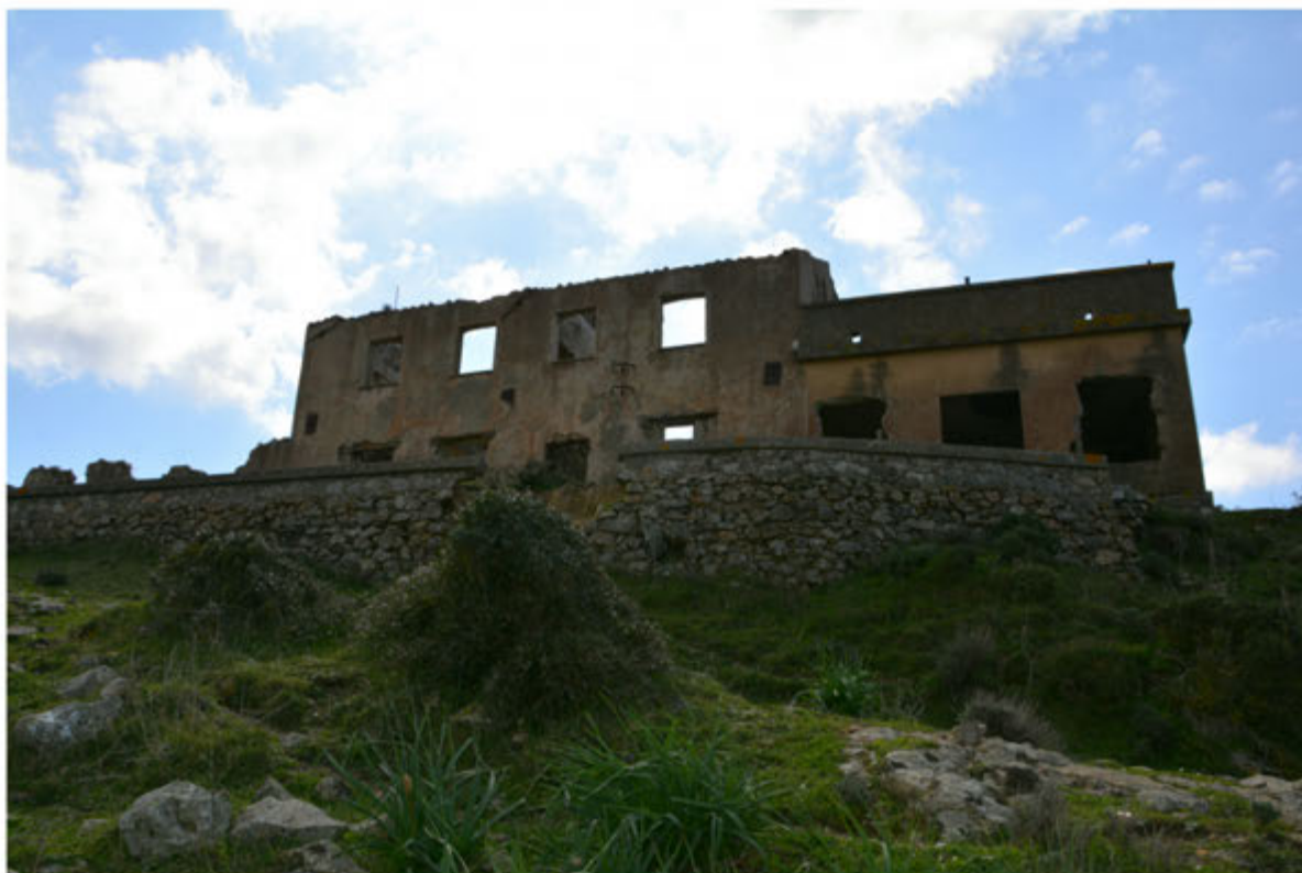
Foto 21: Edificio 6 - Foglio 512 terreno in mapp.31
