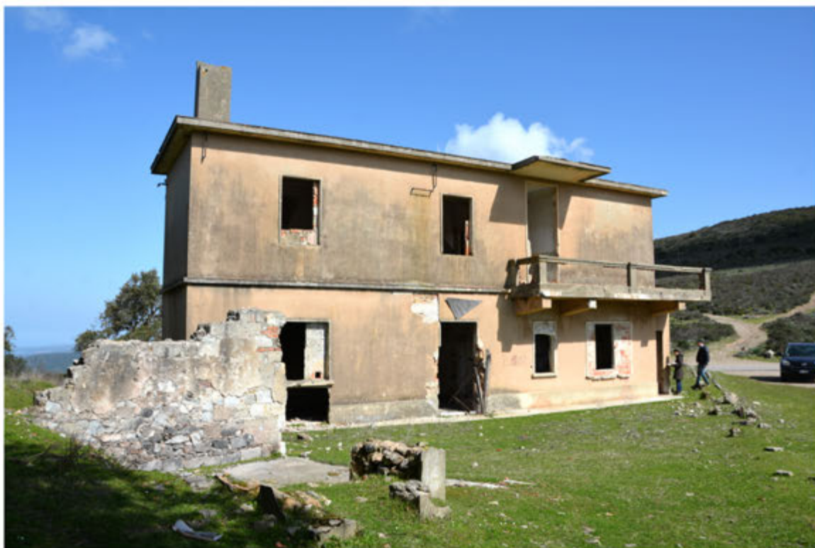
Foto 59: Edificio 22 - Foglio 514 mapp.37
