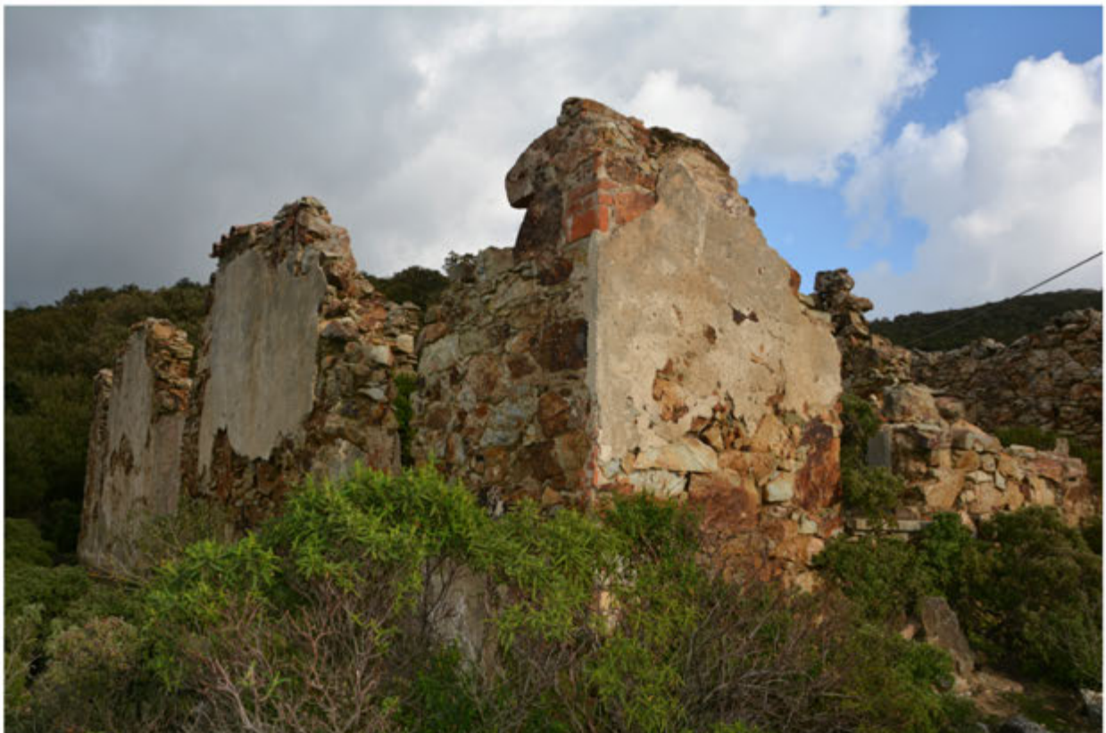
Foto 38: Edificio 11 - Foglio 514 mapp.25
