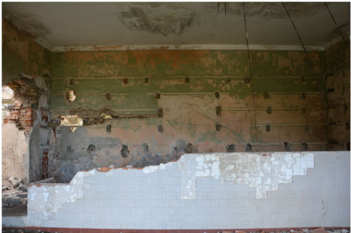
Foto 24: Edificio 6 - Foglio 512 terreno in mapp.31
