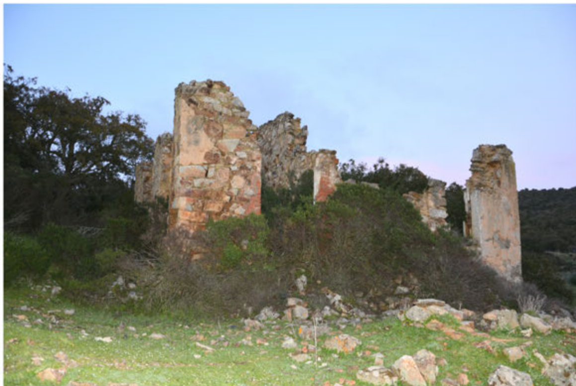
Foto 57: Edificio 20 - Foglio 514 - terreno in mapp.40
