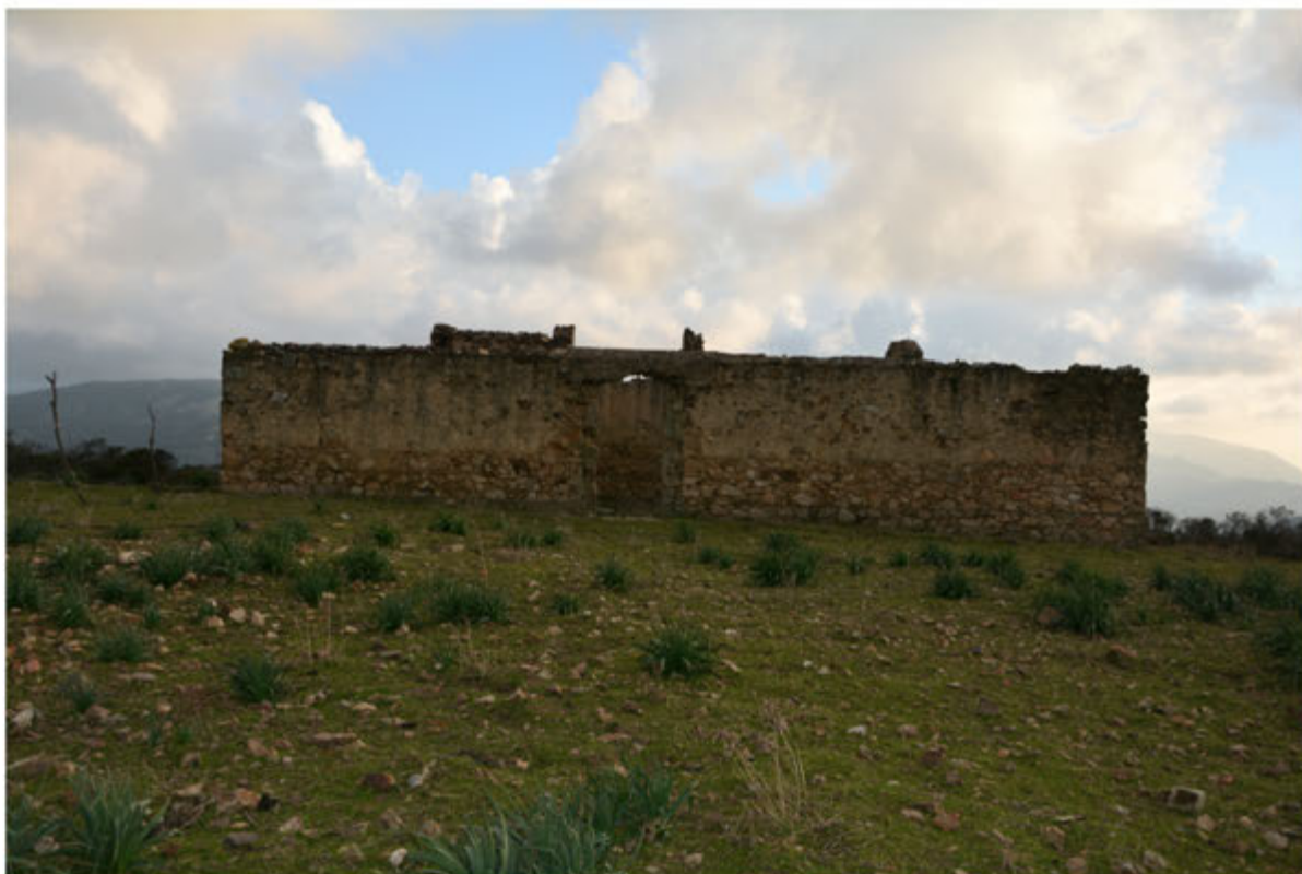
Foto 43: Edificio 14 - Foglio 512 terreno in mapp.63
