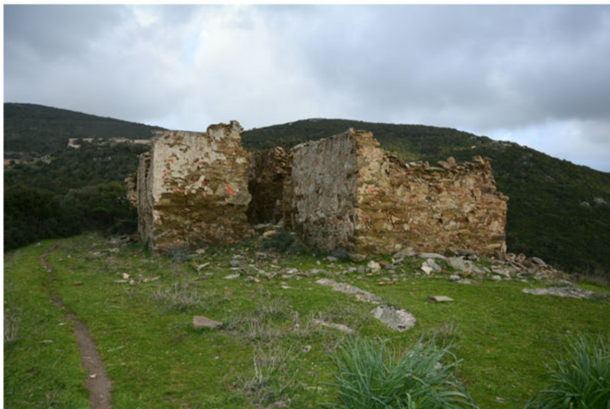
Foto 42: Edificio 13 - Foglio 514 mapp.26
