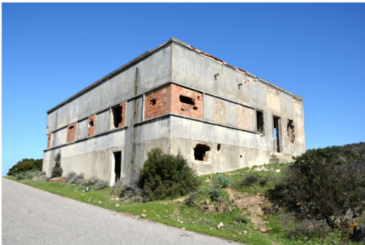
Foto 1: Edificio 1 - Foglio 512, terreno in mappale mapp.65 - Ufficio Postale
