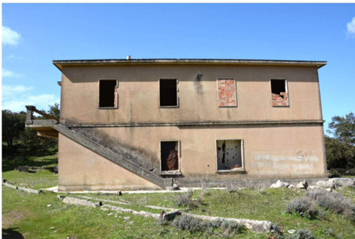
Foto 60: Edificio 22 - Foglio 514 mapp.37
