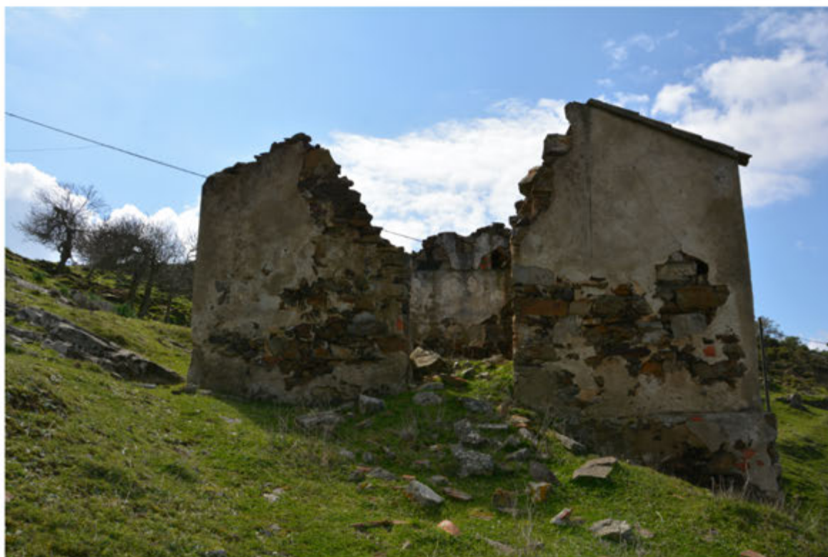
Foto 14: Edificio 4 - Foglio 512 terreno in mapp.58
