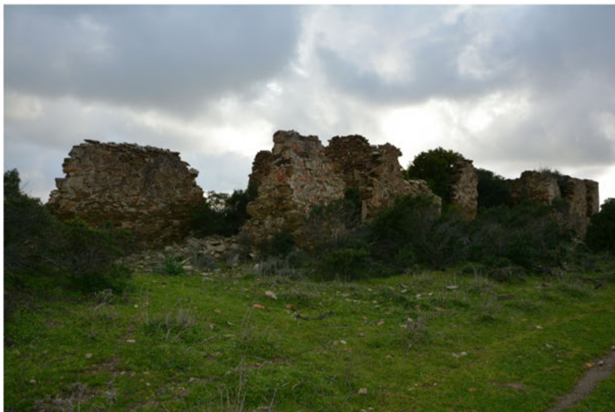
Foto 41: Edificio 13 - Foglio 514 mapp.26
