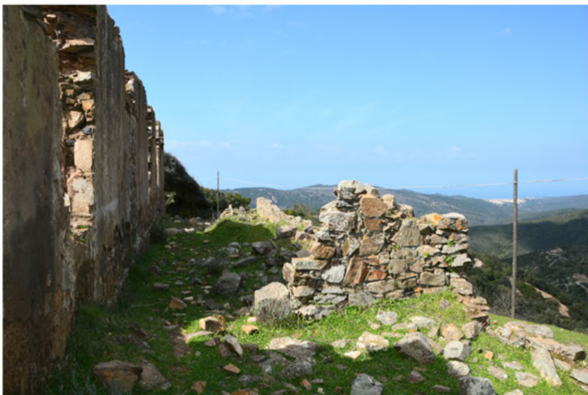
Foto 18: Edificio 5 - Foglio 512 terreno in mapp.58
