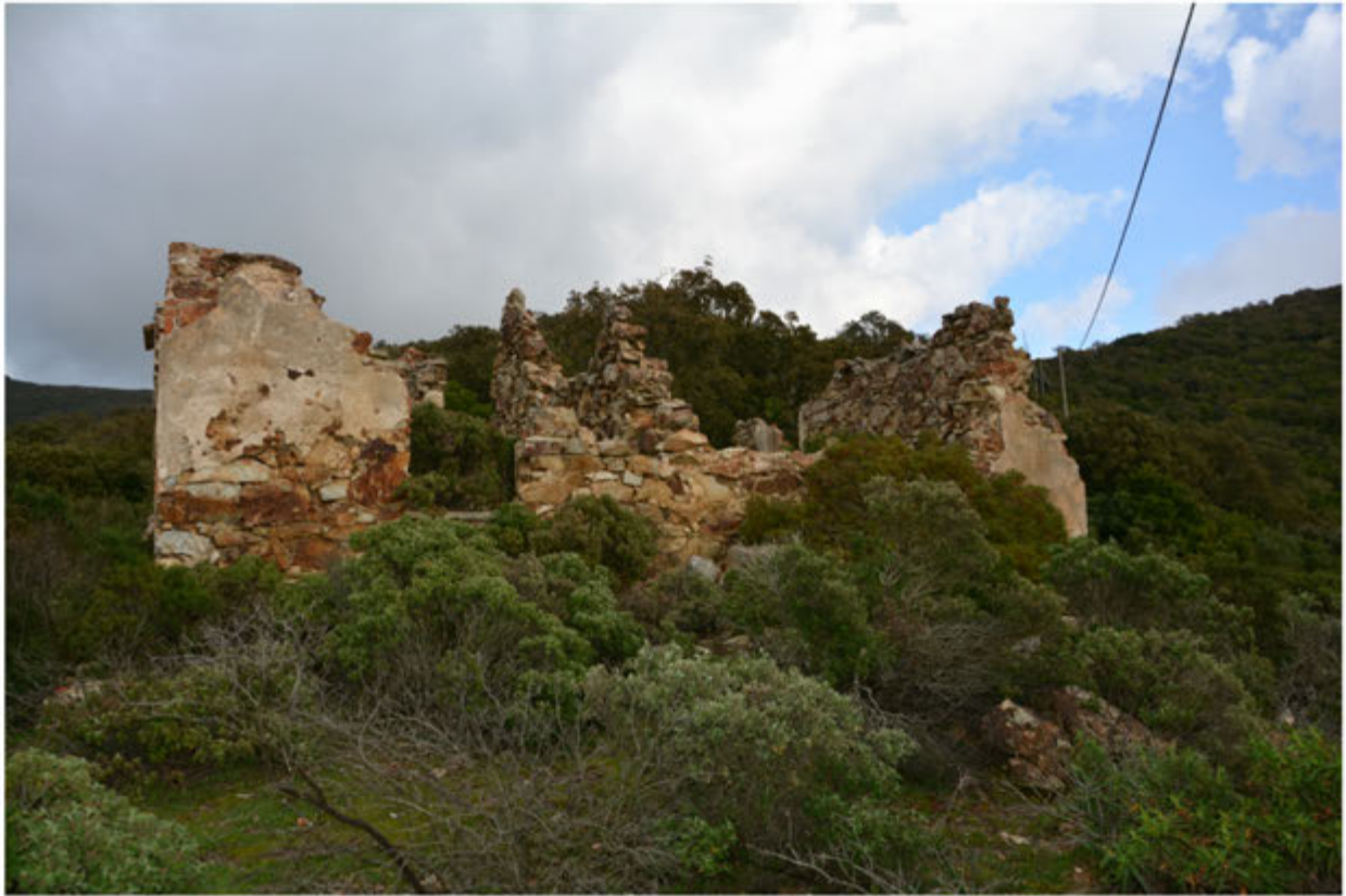
Foto 37: Edificio 11 - Foglio 514 mapp.25
