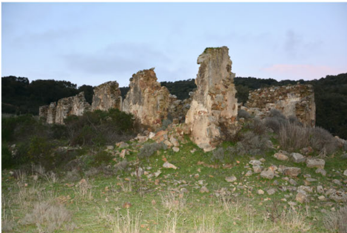
Foto 55: Edificio 19 - Foglio 512 - terreno in mapp.65
