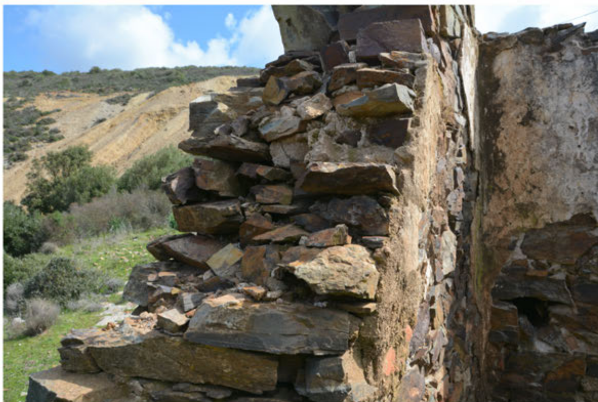
Foto 15: Edificio 4 - Foglio 512 terreno in mapp.58
