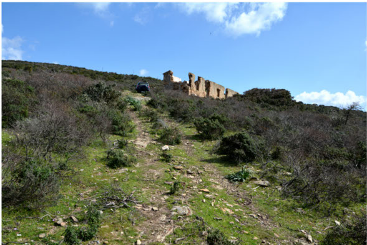
Foto 10: Edificio 3 - Foglio 512 mapp.36
