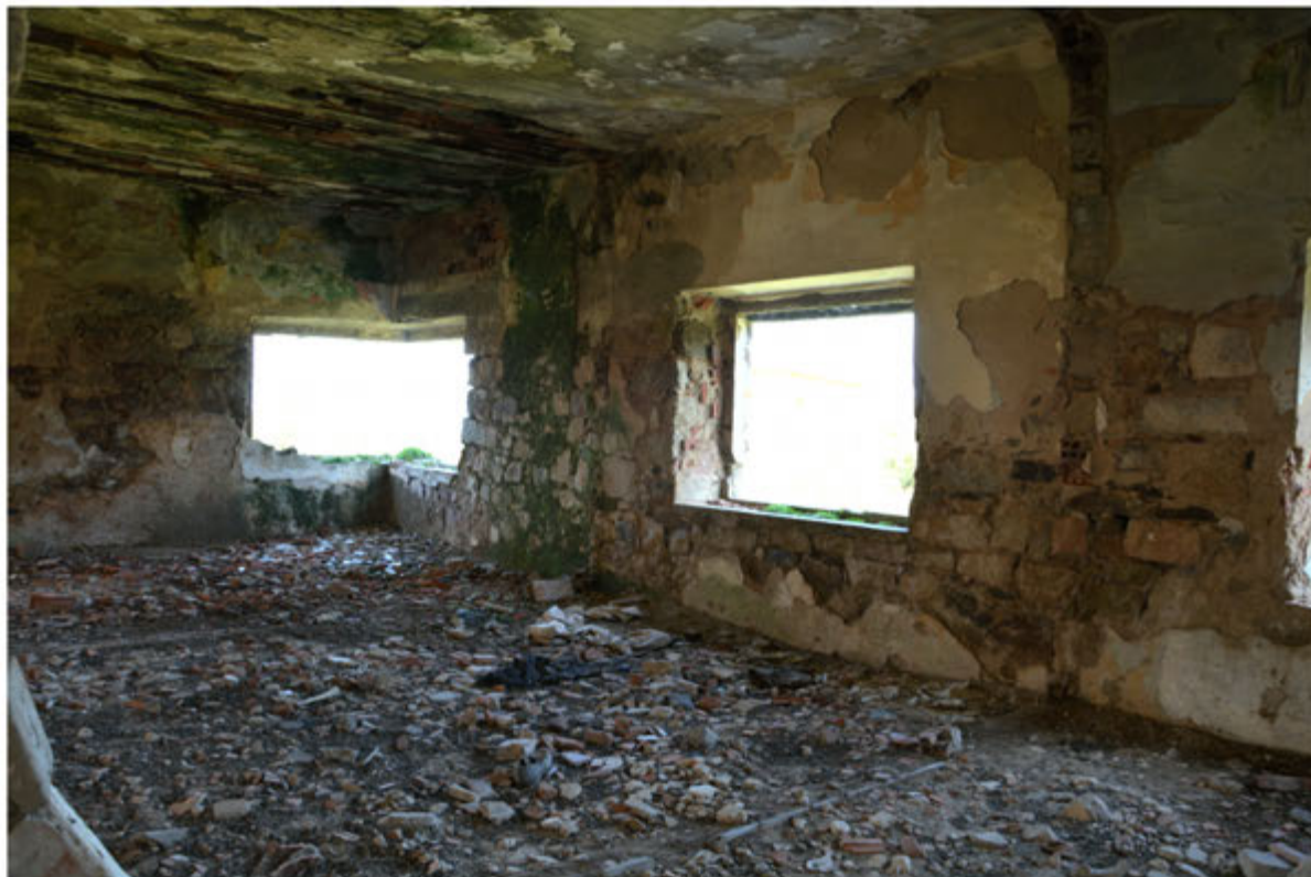
Foto 3: Edificio 1 - Foglio 512, terreno in mappale mapp.65 - Ufficio Postale
