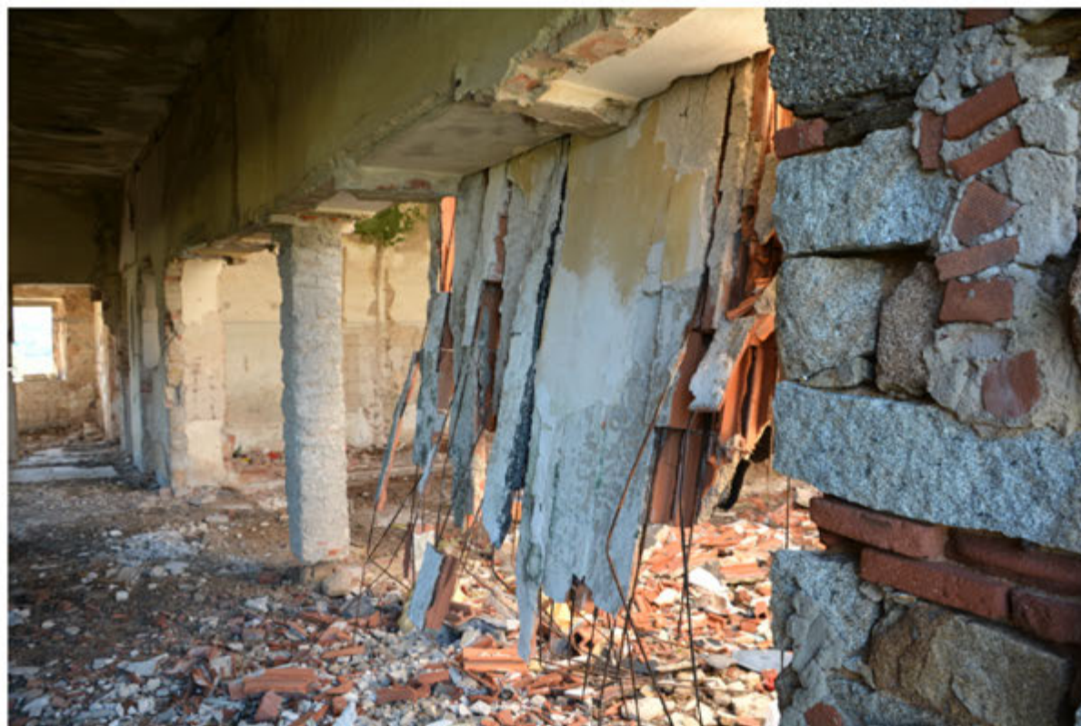
Foto 4: Edificio 1 - Foglio 512, terreno in mappale mapp.65 - Ufficio Postale
