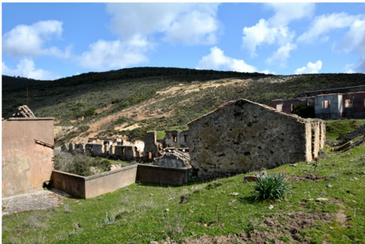
Foto 26: Edificio 7c - Foglio 512 terreno in mapp.31
