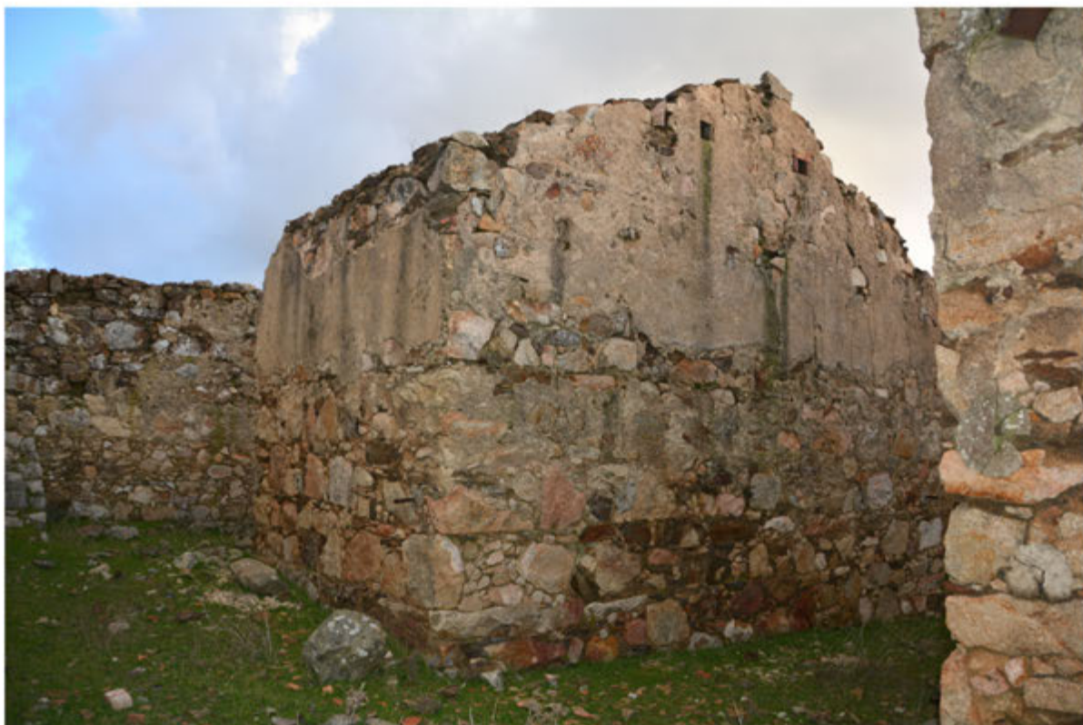
Foto 44: Edificio 14 - Foglio 512 terreno in mapp.63
