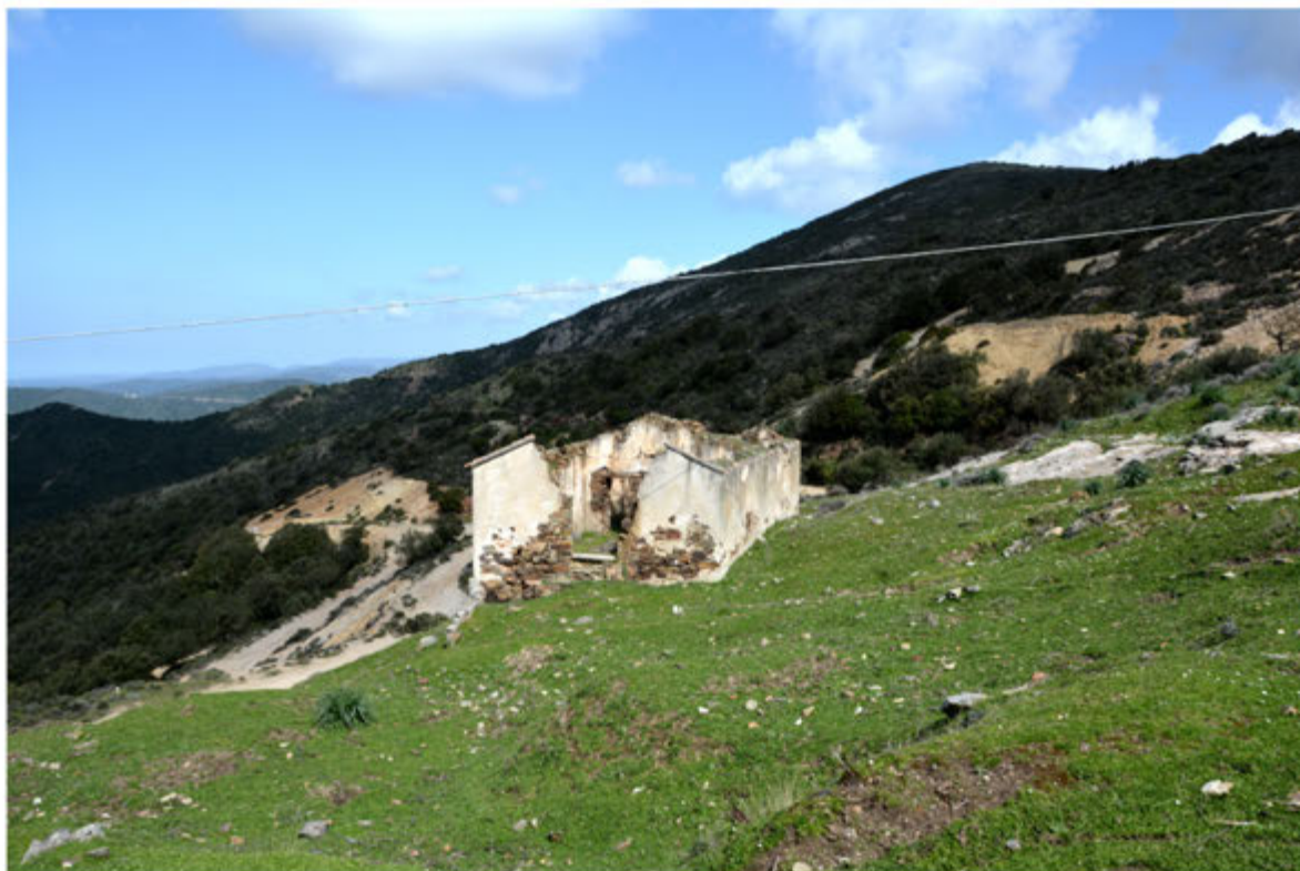
Foto 13: Edificio 4 - Foglio 512 terreno in mapp.58
