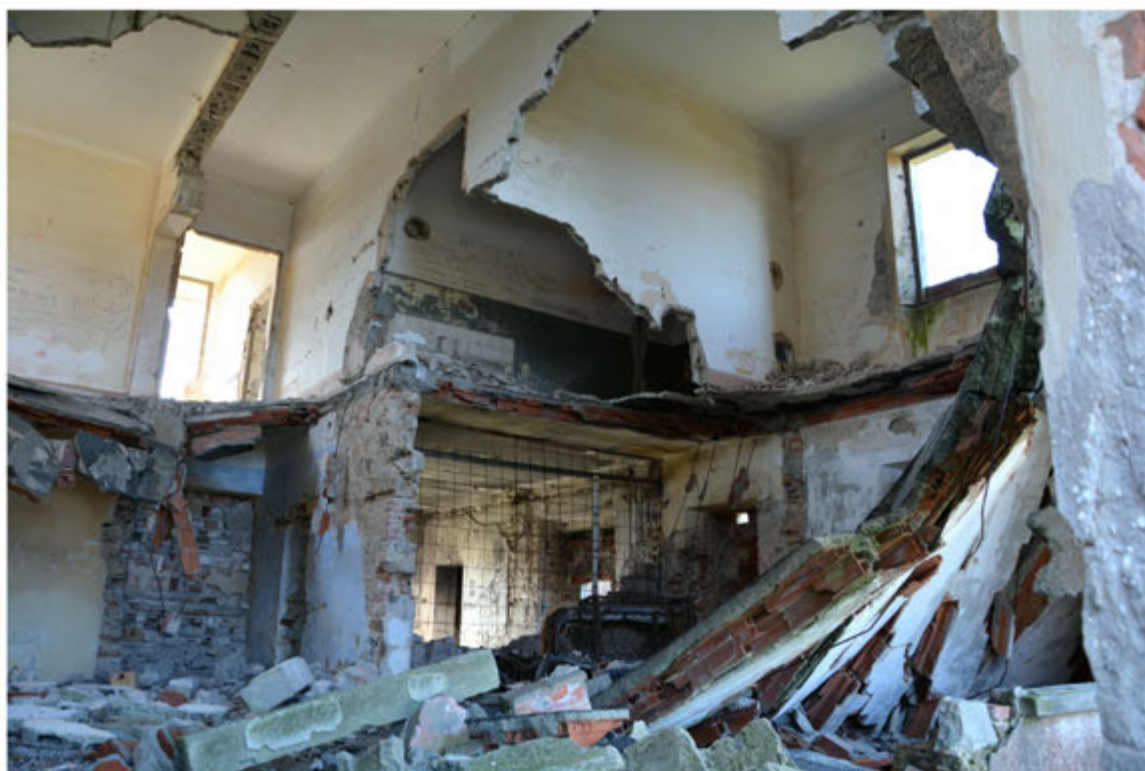
Foto 62: Edificio 22 - Foglio 514 mapp.37
