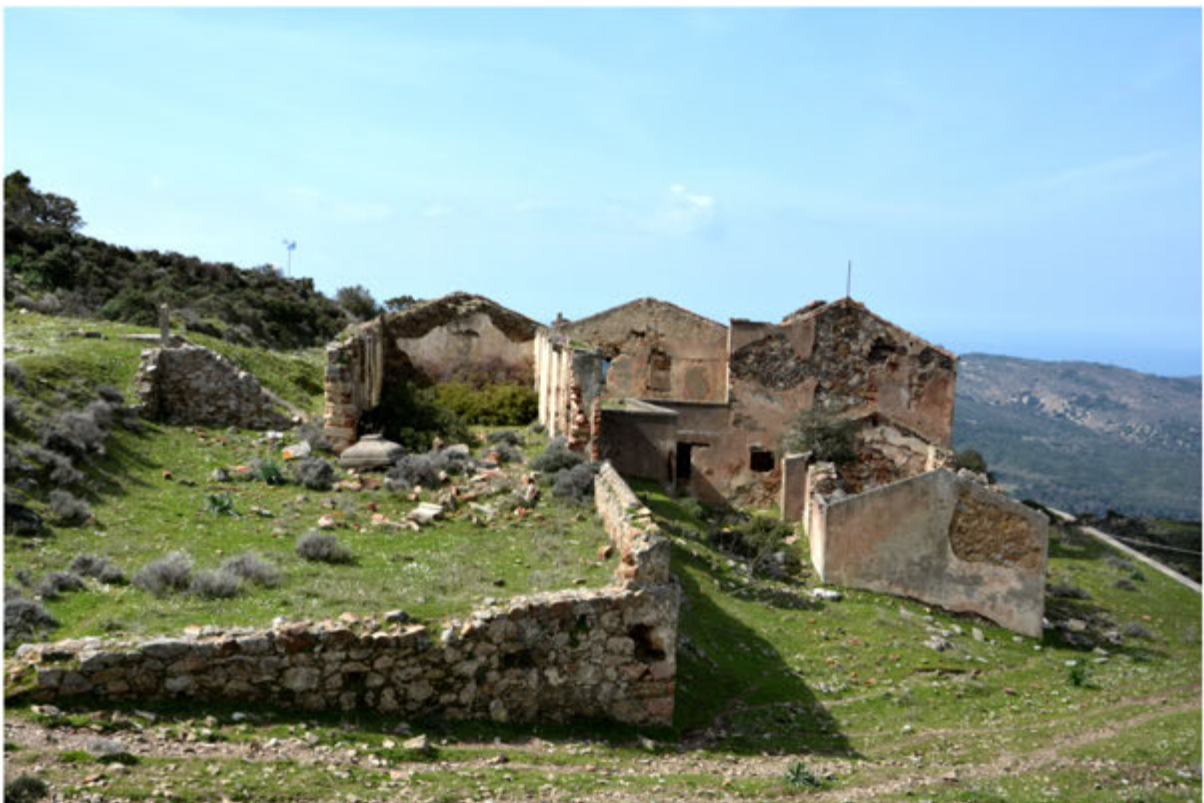
Foto 20: Edificio 6 - Foglio 512 terreno in mapp.31
