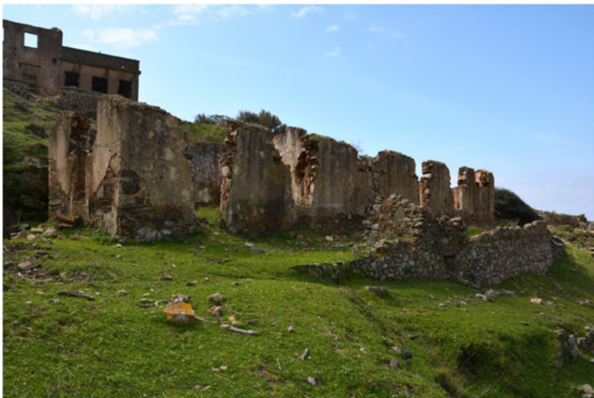
Foto 17: Edificio 5 - Foglio 512 terreno in mapp.58
