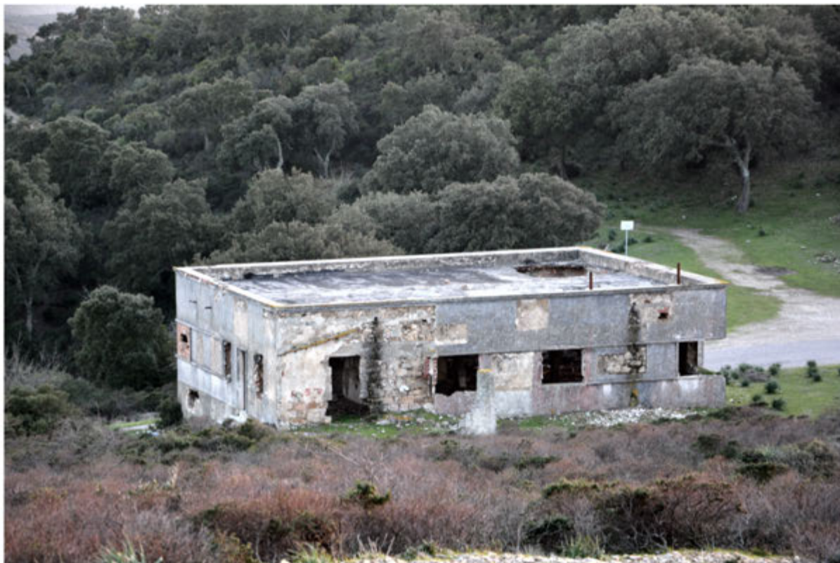
Foto 2: Edificio 1 - Foglio 512, terreno in mappale mapp.65 - Ufficio Postale
