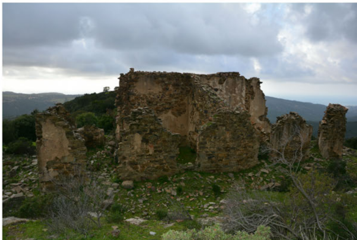
Foto 40: Edificio 12 - Foglio 514 terreno in mapp.38
