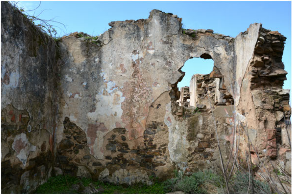
Foto 19: Edificio 5 - Foglio 512 terreno in mapp.58
