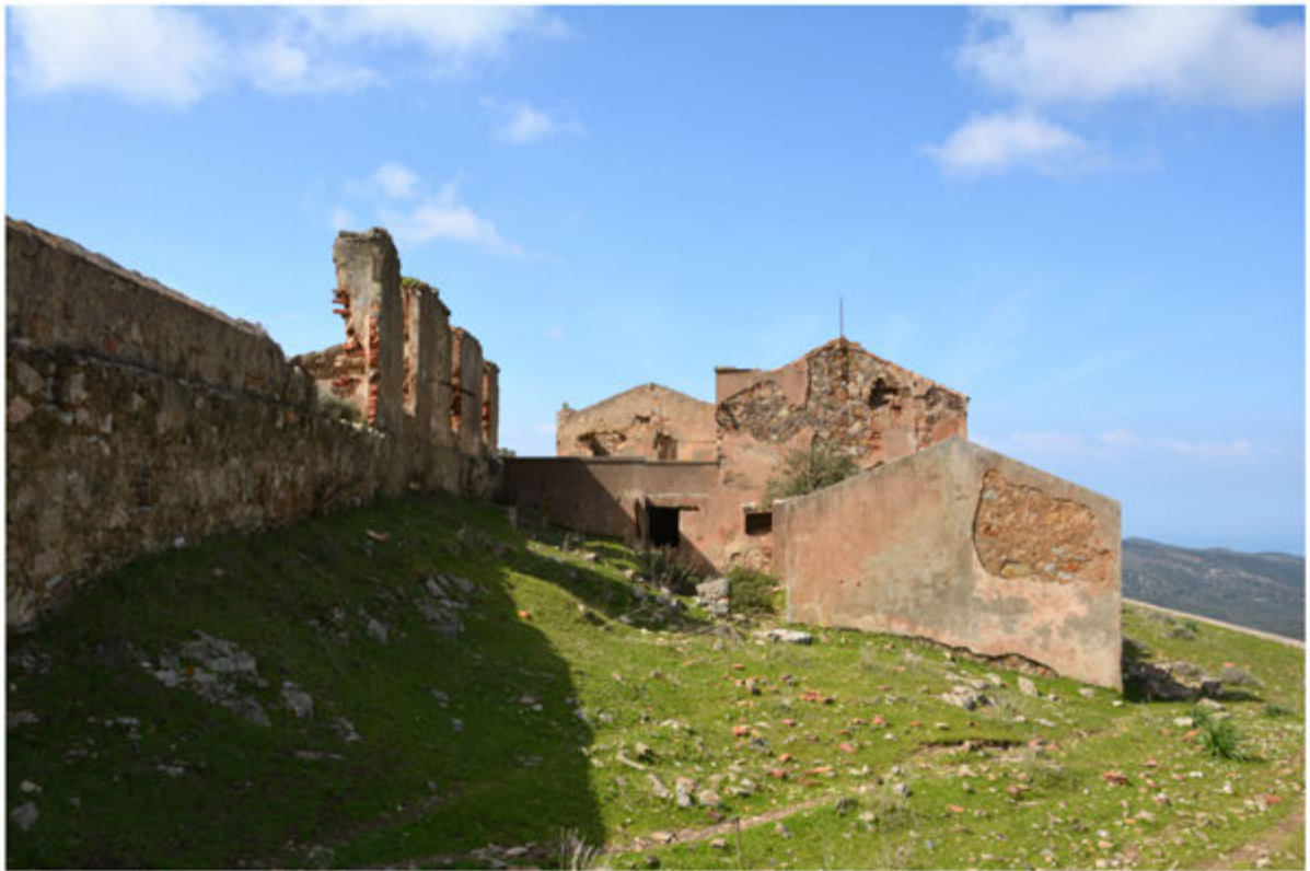
Foto 23: Edificio 6 - Foglio 512 terreno in mapp.31
