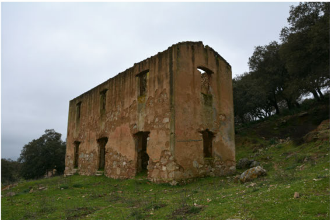
Foto 20: Foglio 512 rudere c in terreno mapp.58
