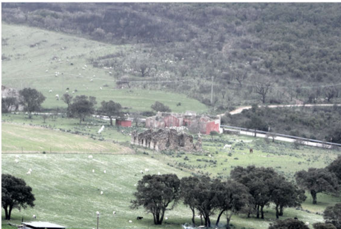
Foto 26: Foglio 512 rudere y in terreno mapp.66
