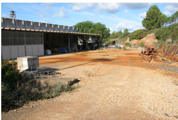
Foto 3 - esterno capannone magazzino
