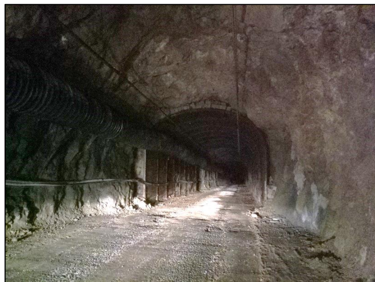
Fig.11. Tratto armato dopo la prima "camera"
