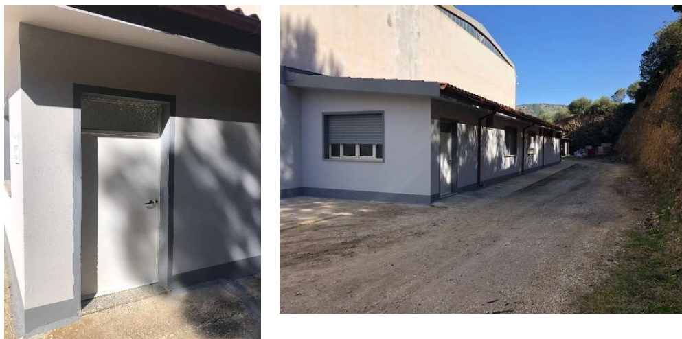
Vista posteriore del Laboratorio in Superficie
