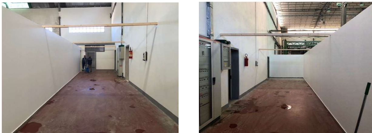
Situazione attuale del corridoio in cartongesso da coprire
